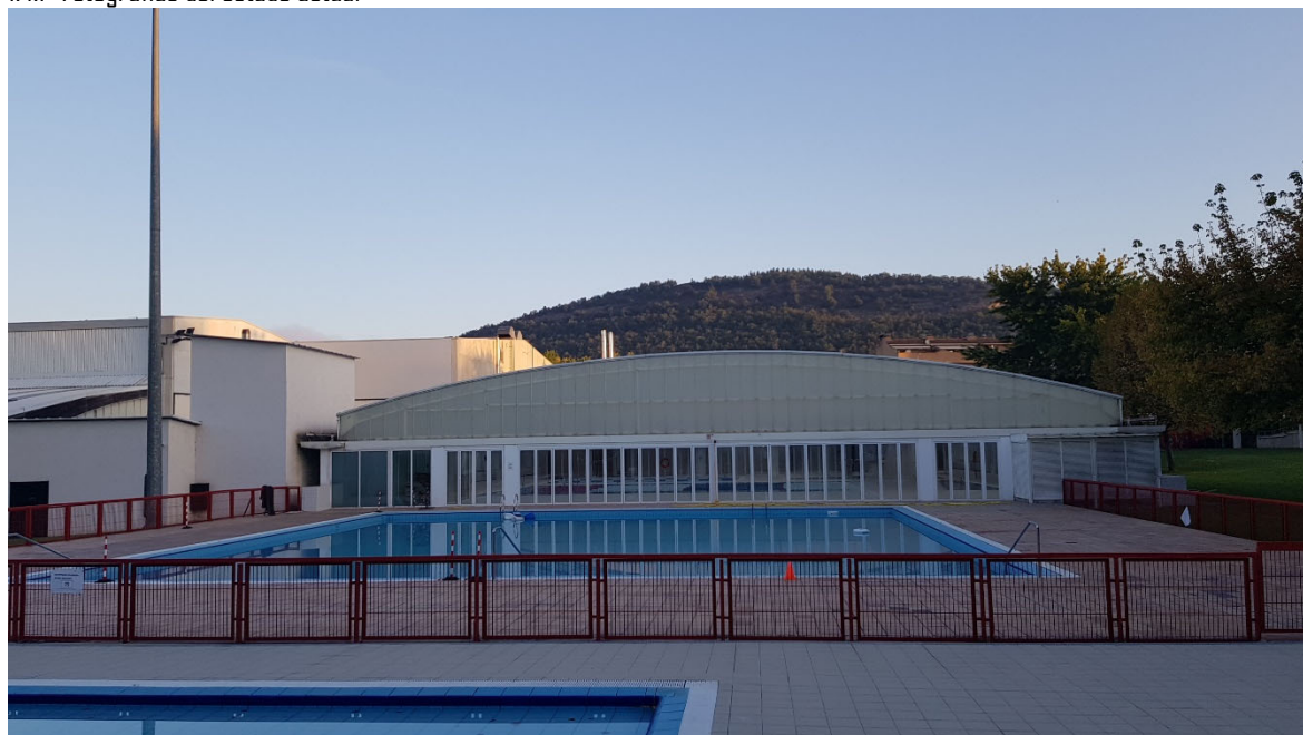
Vista general de la piscina mediana
