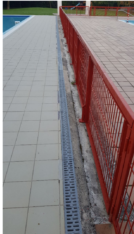
Vista playa separación con piscina chapoteo
