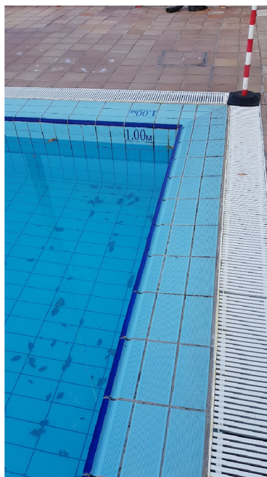
Vista borde noroeste piscina
