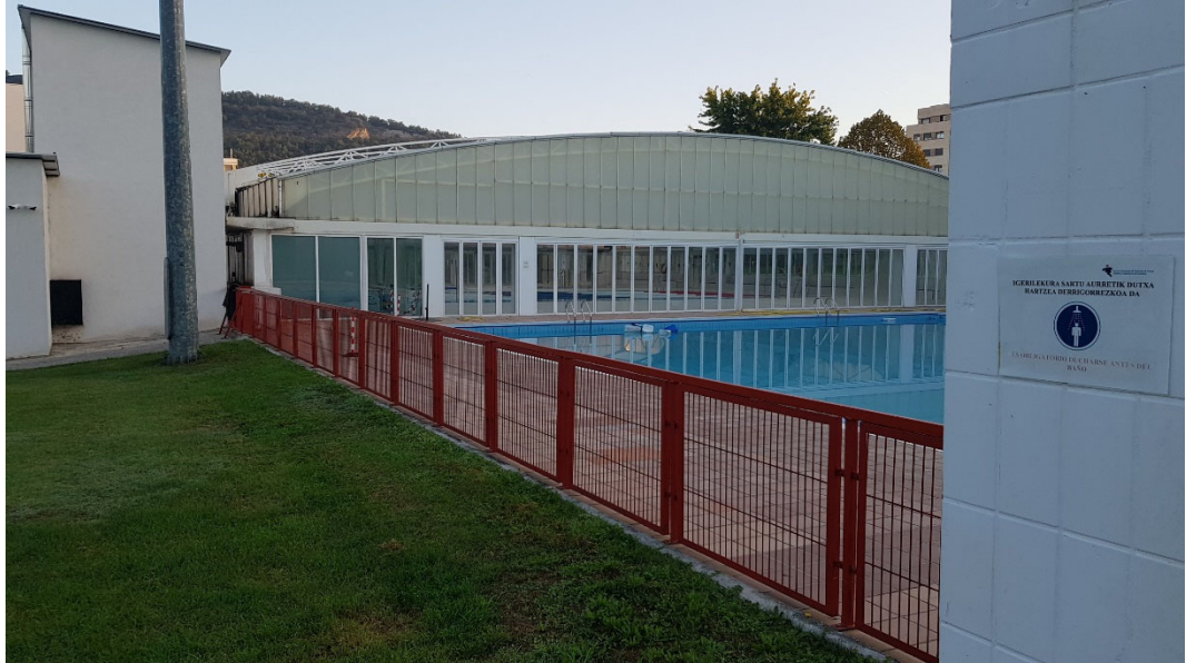
Vista desde el suroeste de la piscina mediana
