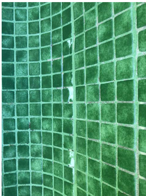
4._ Piezas rotas, encuentro paramento vertical con media caña, genera lesiones.
