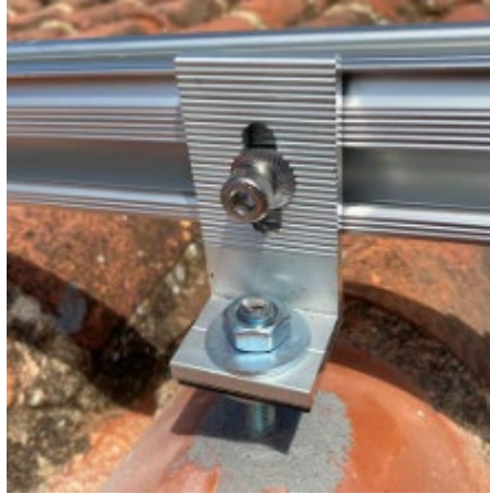
Ilustración 9: Ejemplo montaje panel solar fotovoltaico coplanar
