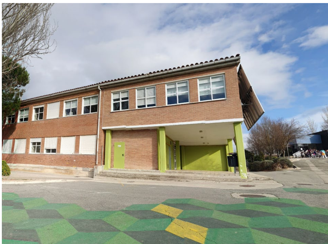
Ilustración 22: Imagen del edificio desde el exterior
