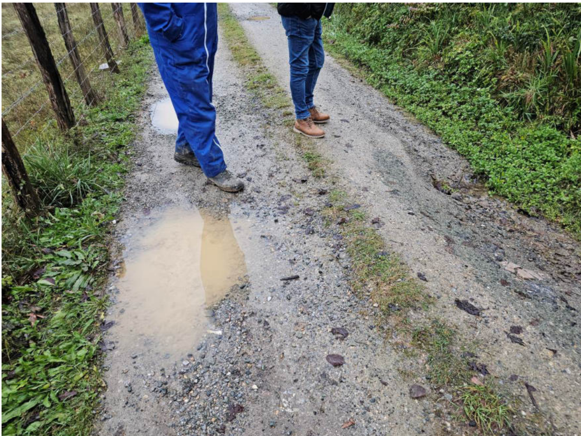
Otra fotografía del camino Kankan tramo 1
