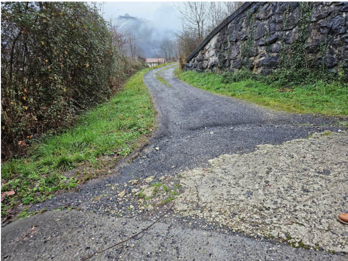
Otra fotografía del camino Kankan tramo 2
