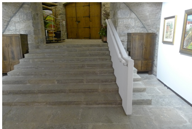
Escalera de acceso planta baja
