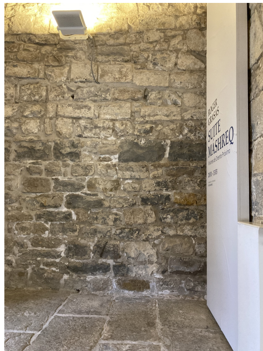
Muro separación naves (acceso ascensor)
