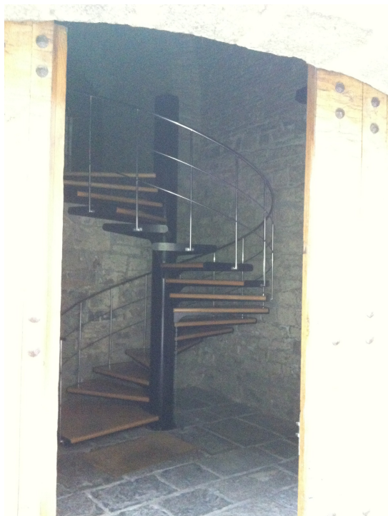
Escalera de acceso planta primera
