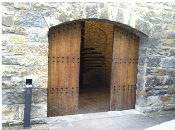
Puerta de acceso principal
