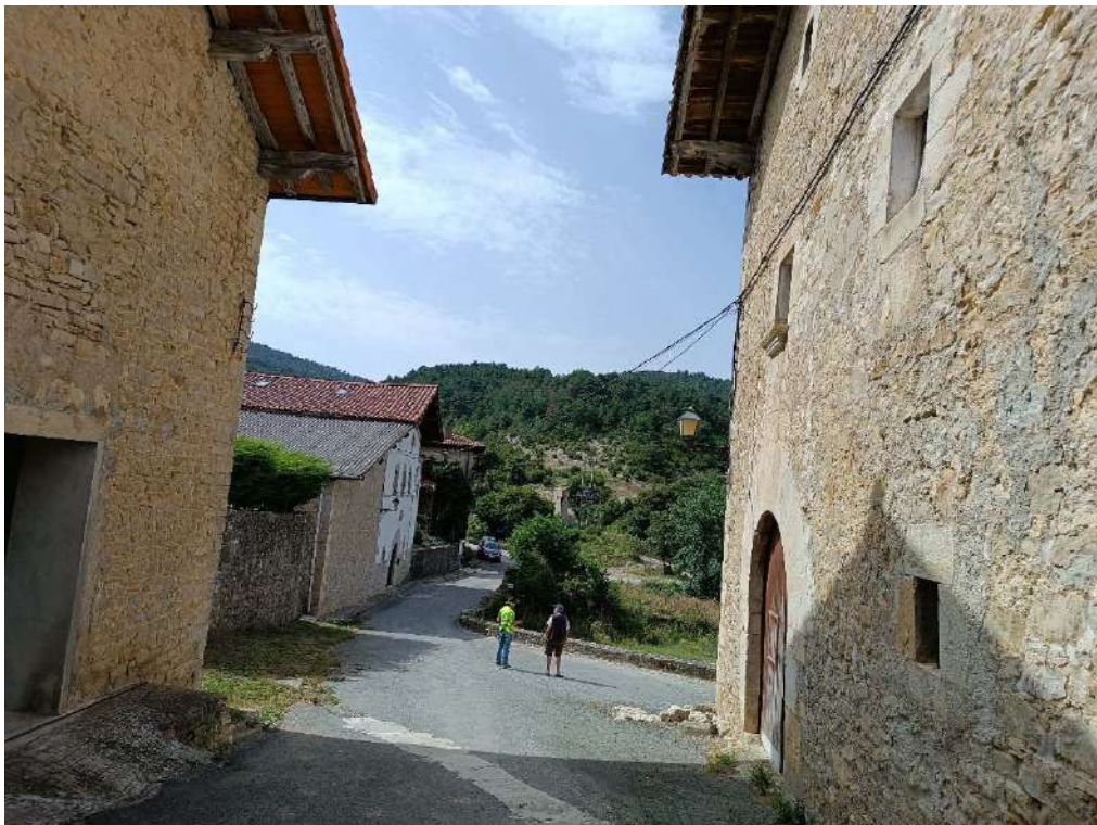
Imagen 18. C/ la Virgen nº4 y nº8. Zanja de cruce de redes enterradas. Foto 2
