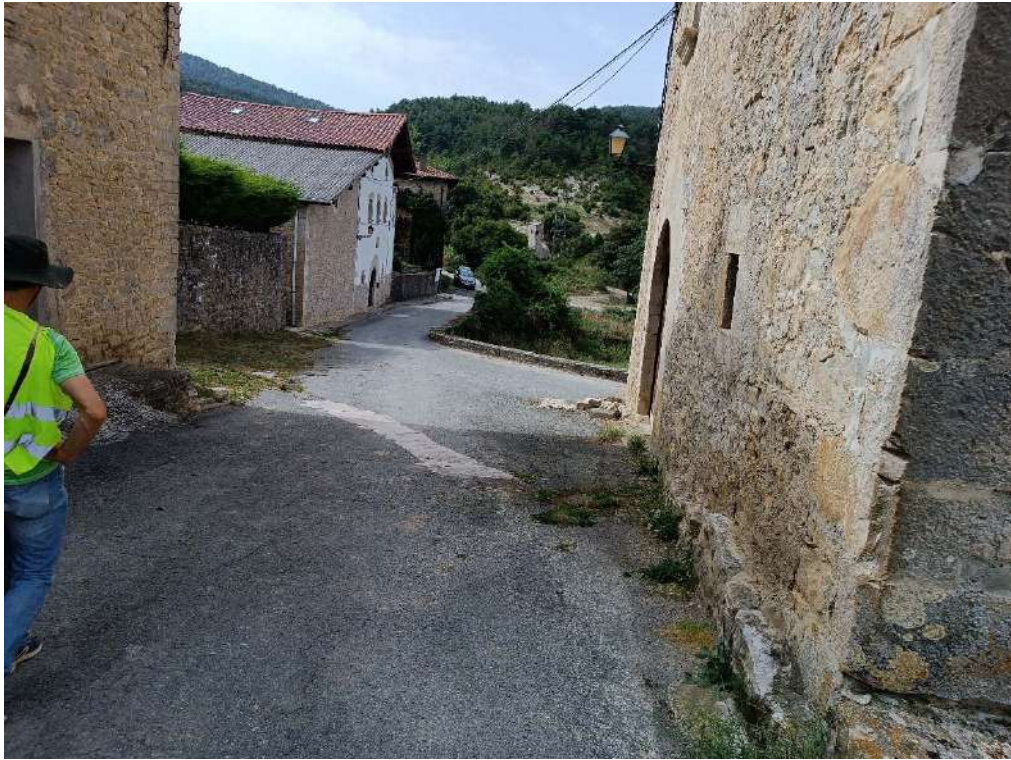
Imagen 17. C/ la Virgen nº4 y nº8. Zanja de cruce de redes enterradas. Foto 1
