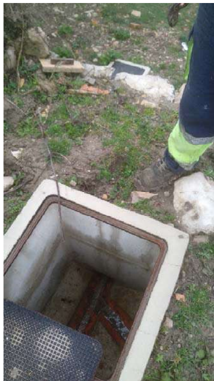
Imágenes 33 y 34. Arqueta de entronque con la red de fecales existente
