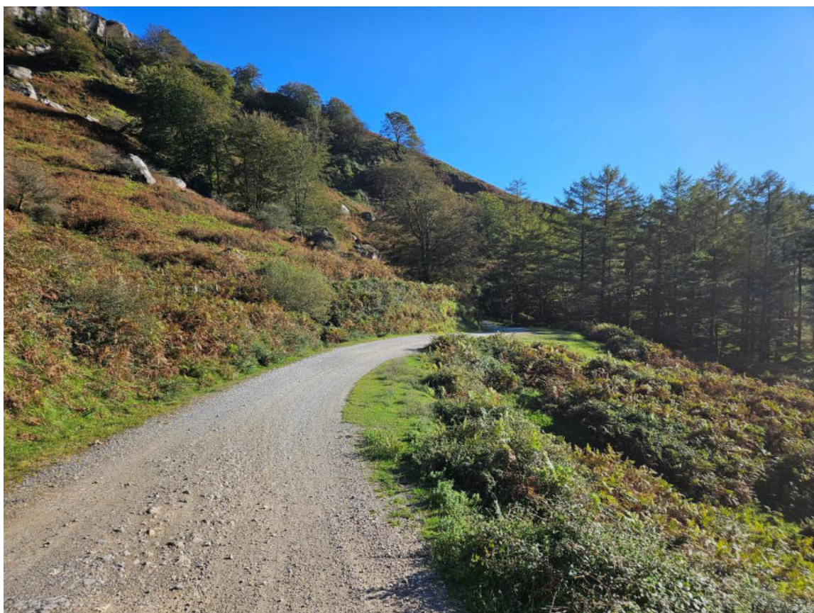
Fotografía del estado actual del tramo Lezetako Bidea con apenas zahorras artificiales y sin finos (Gravas sueltas)
