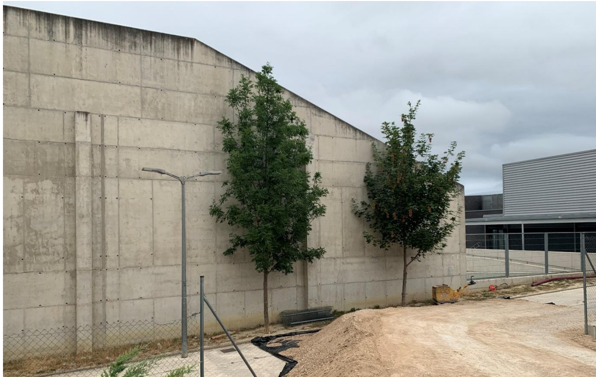
Vista de la pared lateral por su trasera. Se observan las pilastras de refuerzo.
