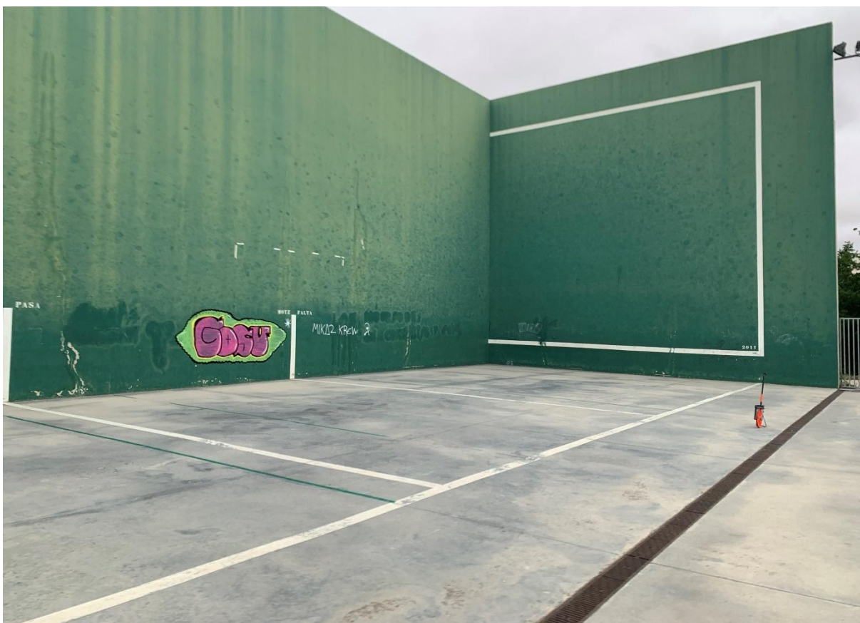
Frontón. Una canaleta corrida recoge las aguas de escorrentía de la cancha y un poste
