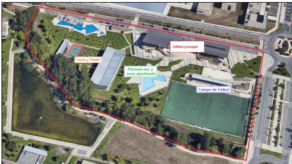
Imagen. Instalación objeto de proyecto
