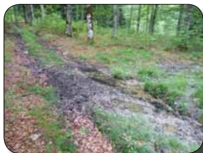
Mikeo, encharcamiento en un drenaje inoperativo
