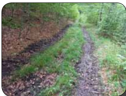
Mikeo, rodadas y empradizamiento en el eje de la vía
