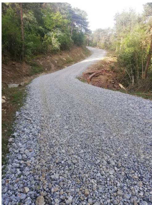
Imagen 1: Parte del afirmado se efectúa sobre tramos con subbase saneada con magnesita en el marco del Next Generation.-
