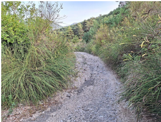
Imagen 3: Camino del repetidor, Irotz. Estado actual.-
