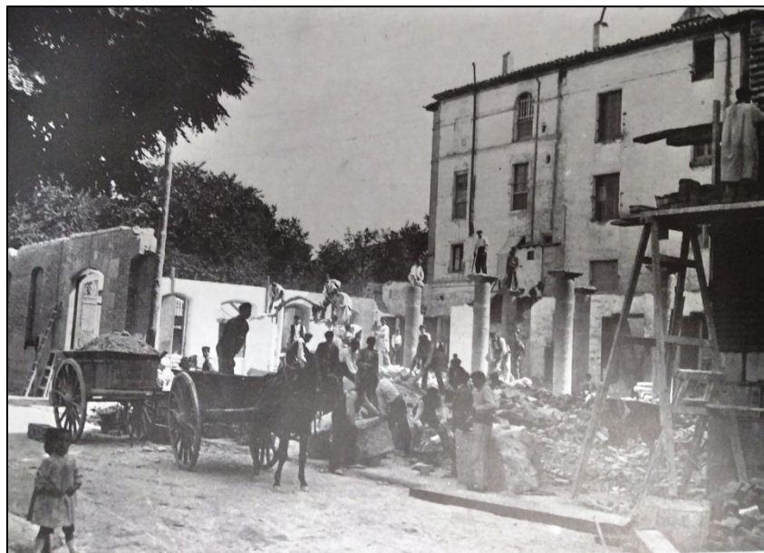
Fig. 40.- Derribo de parte del edificio del Vínculo para construir la casa de Correos y Telégrafos. (ARAZURI, 1980, III: 298)
