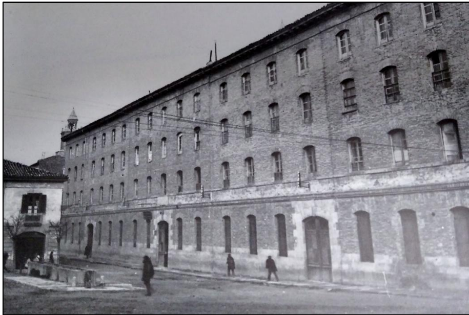
Fig. 39.- Fachada oeste del edificio del Vínculo en una imagen de 1914. (ARAZURI, 1980, III: 298)
