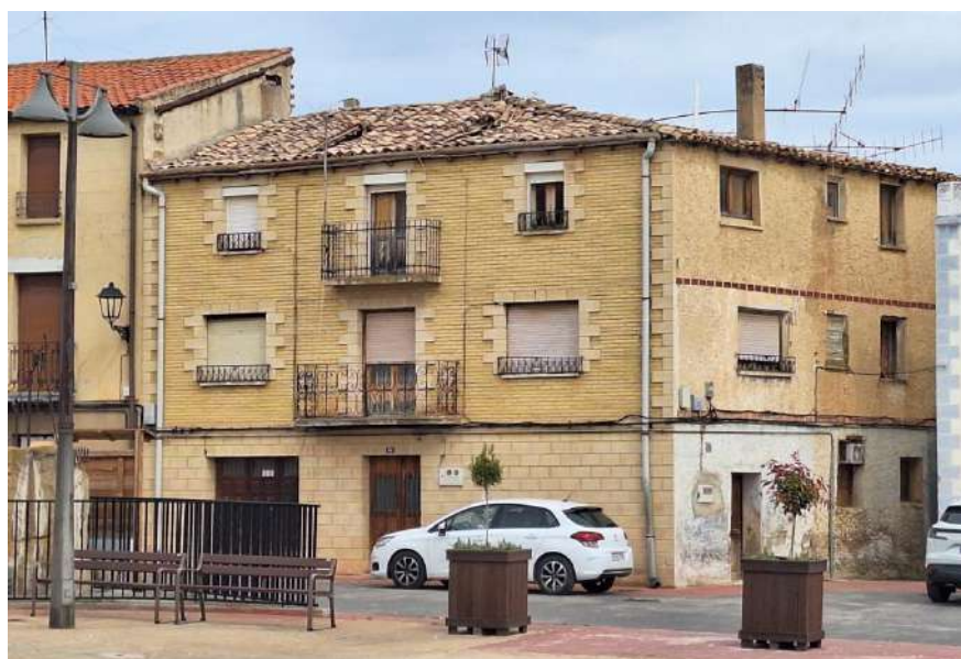
Vista actual de fachada a plaza
