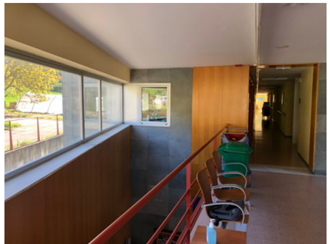
Foto 4: Vestíbulo planta primera
