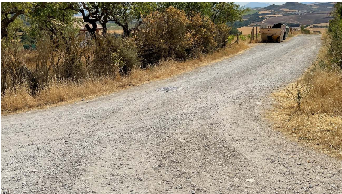
FOTO 3. TRAMO 2 a viviendas existentes.
