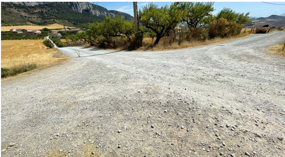
FOTO 4. Cruce en mitad del tramo 1 con tramo 2 a zona residencial
