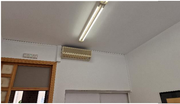
Local 205 Regletas con dos fluorescentes de 36 W, sustituidas por LED.
