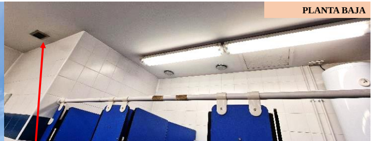
Rejillas interiores para la extracción de aire de los vestuarios
