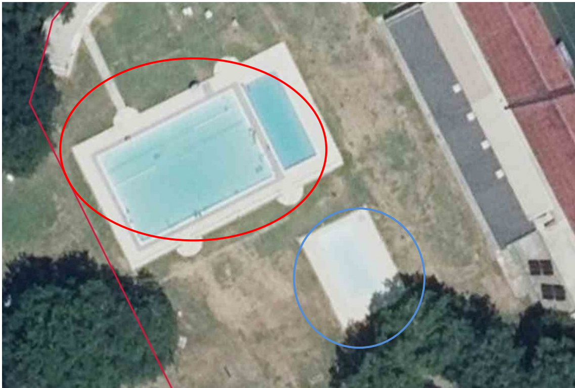
Piscinas en las Instalaciones Deportivas Dantzaleku.
