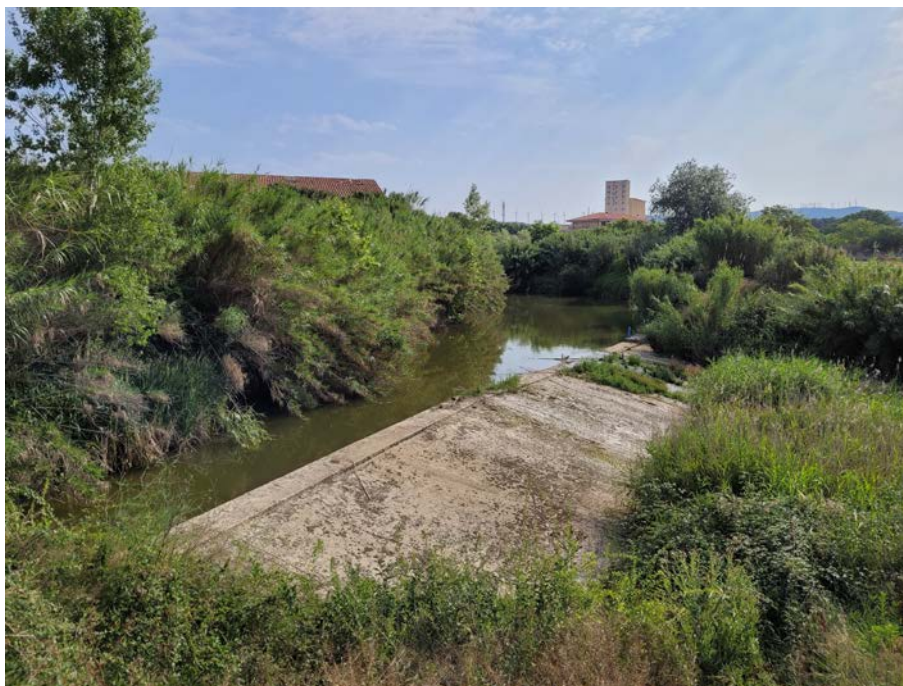
Presa de Los Frailes
