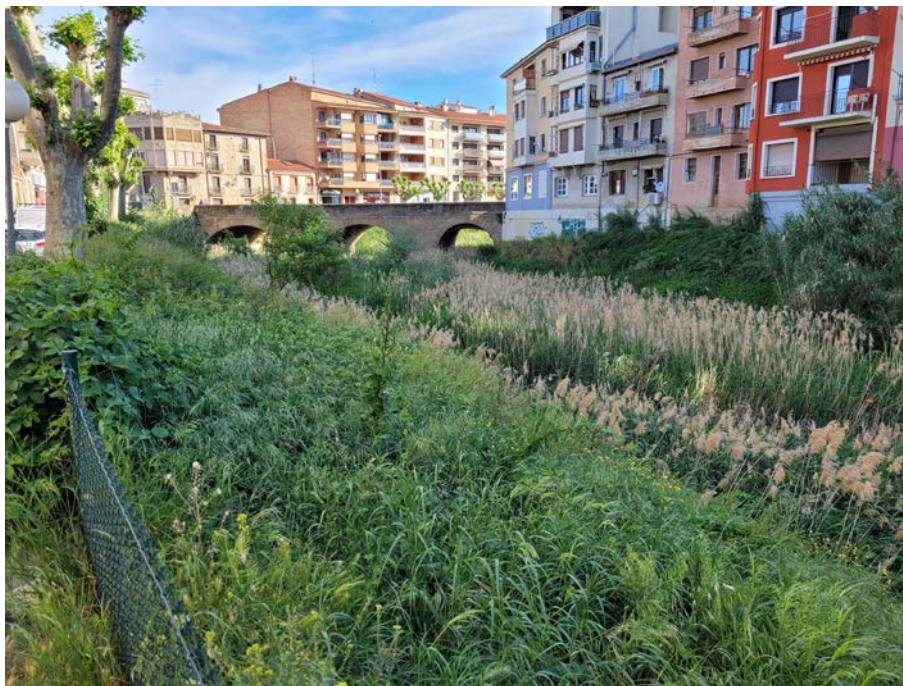
Zona del Puente de la Estación
