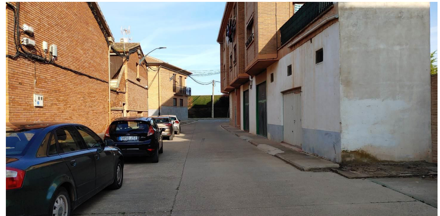
Tramo calzada Ximénez Palacios
