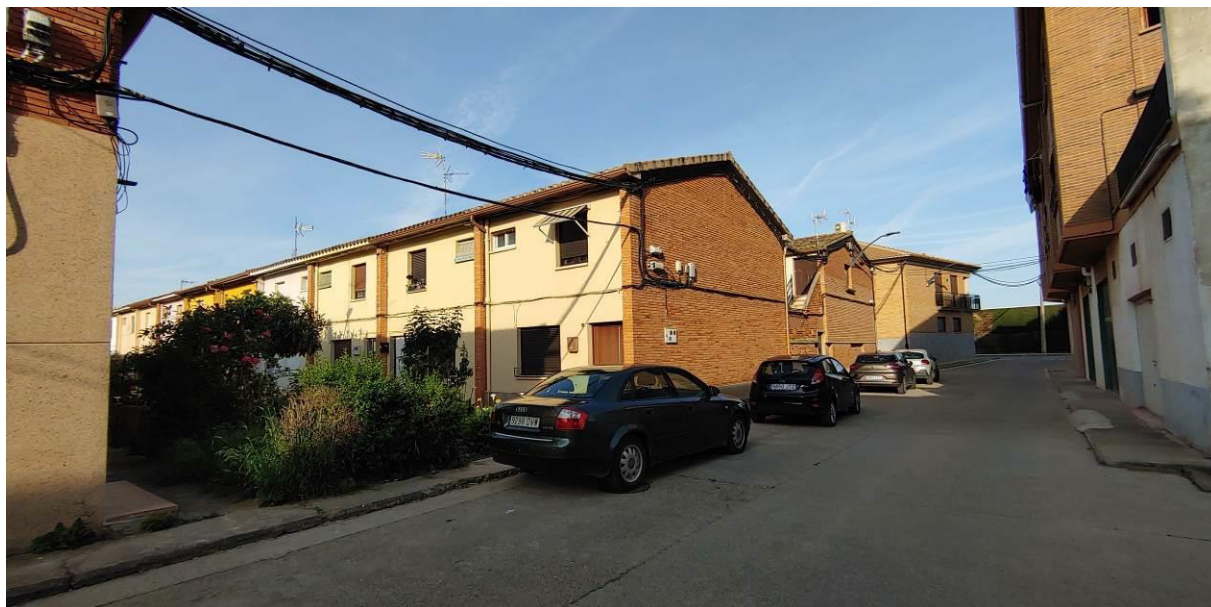
Tramo calzada Ximénez Palacios
