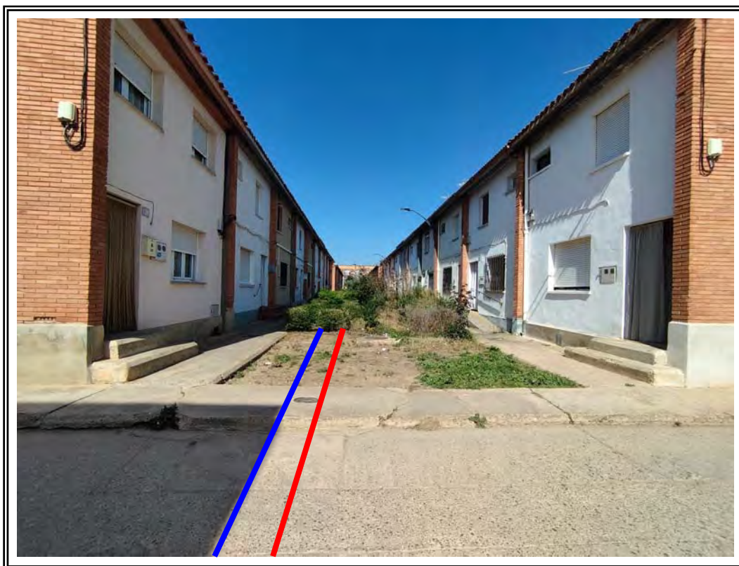
FOTO 1 – Vista de Sur a Norte
