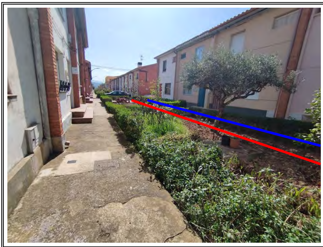
FOTO 12 – Vista de Norte a Sur
