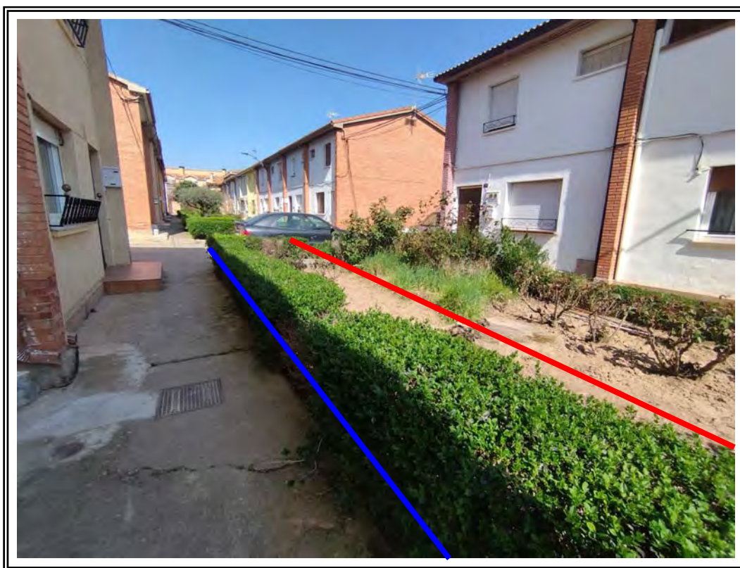
FOTO 4 – Vista de Sur a Norte
