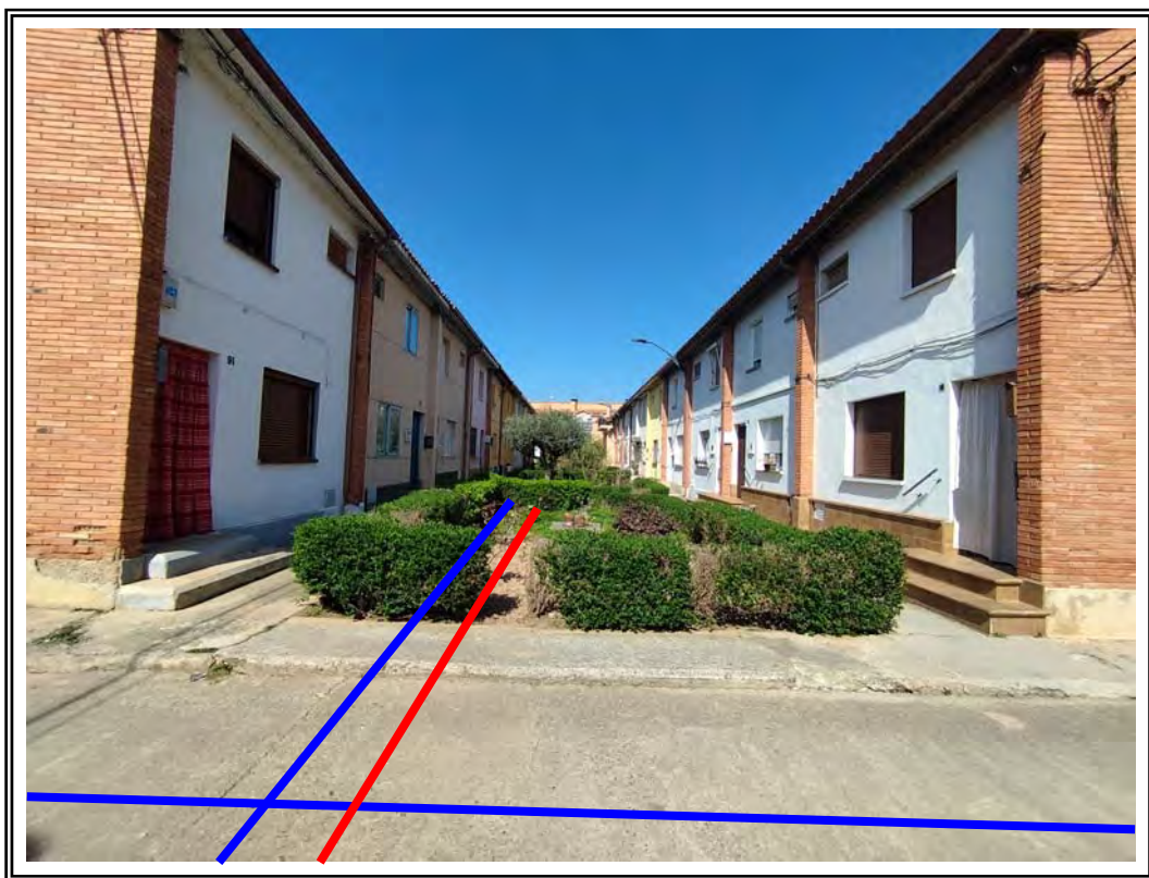
FOTO 5 – Vista de Sur a Norte
