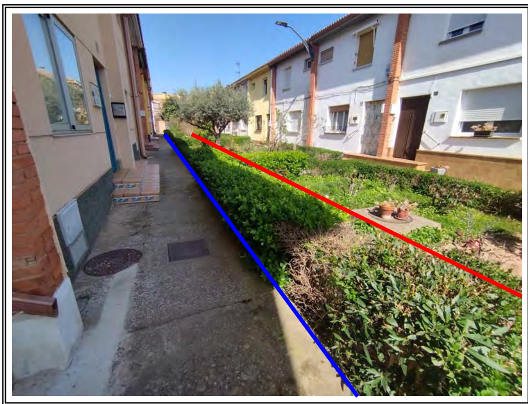
FOTO 6 – Vista de Sur a Norte
