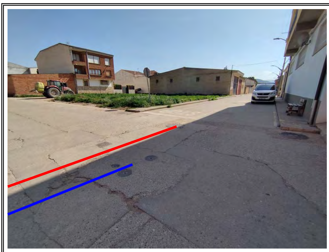
FOTO 18 – Vista de la conexión en el extremo Sur
