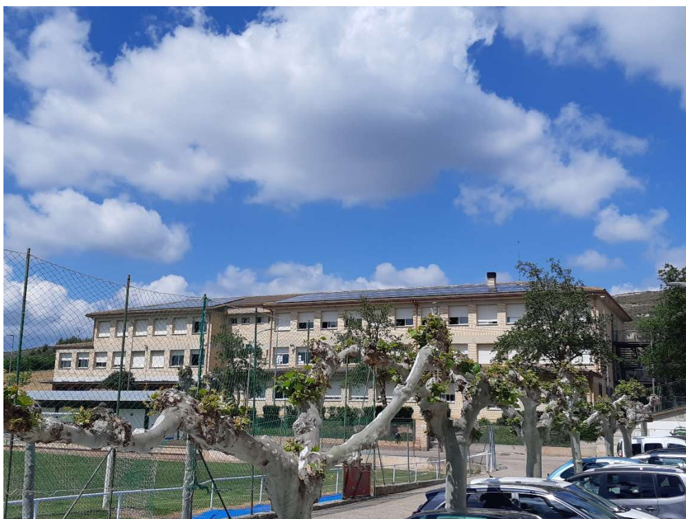
Vista general del Colegio
