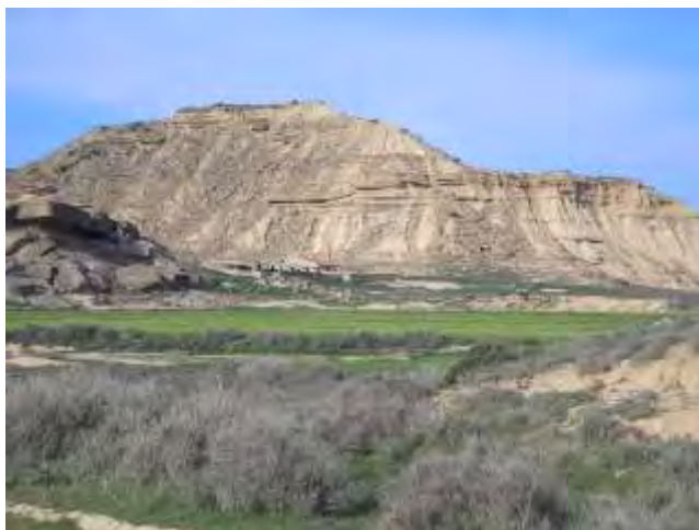
Vista general del conjunto de construcciones: barrera; corral con serenado y cabaña aneja.
