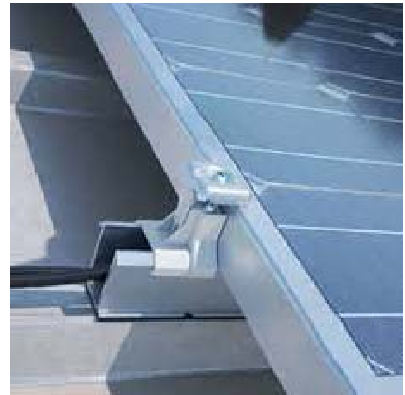
DETALLE SUJECIÓN PANEL CUBIERTA METÁLICA
