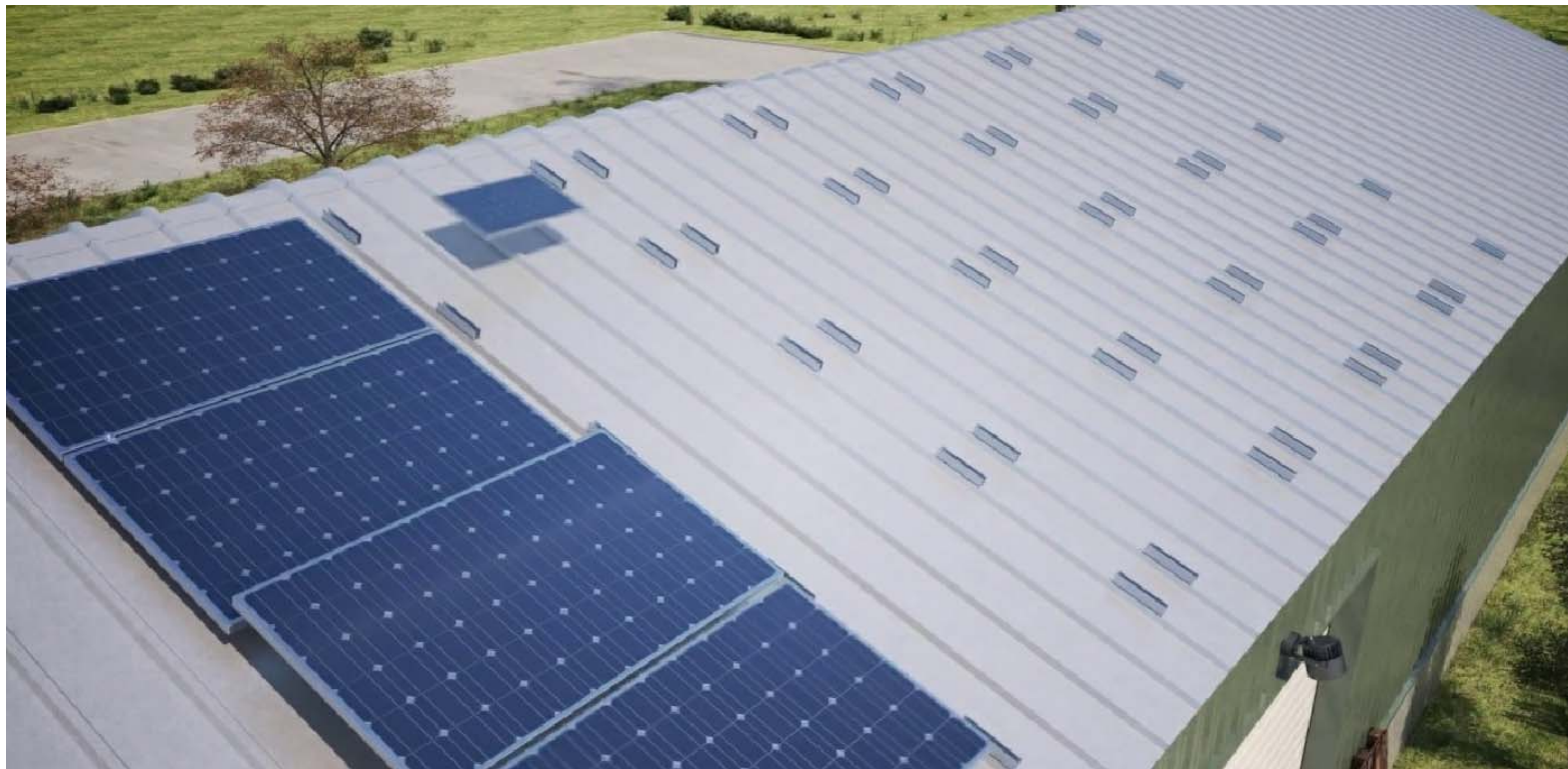
DETALLE INSTALACIÓN COPLANAR MODULOS FOTOVOLTAICOS
