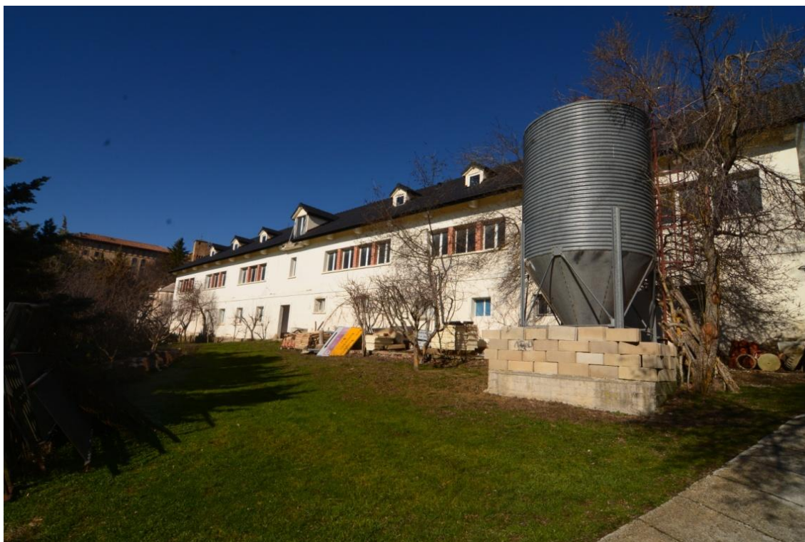
Imagen. 9. Edificio existente y zona de implantación de módulos fotovoltaicos.
