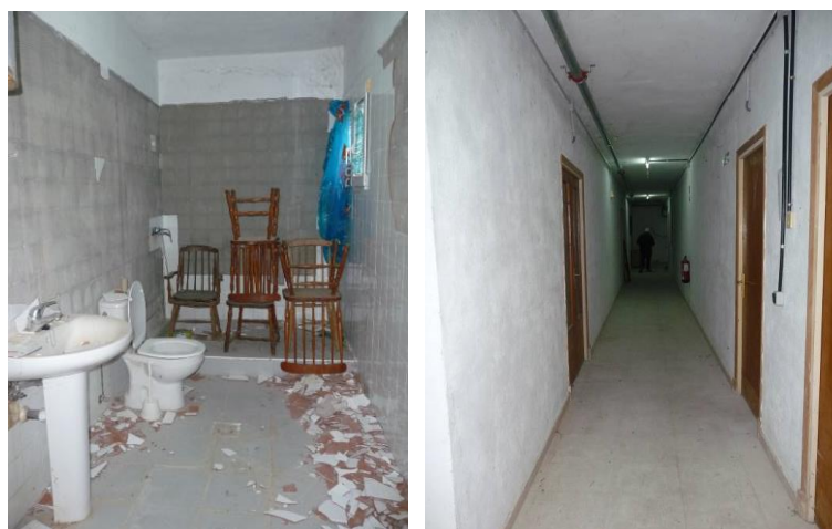
Espacios y talleres en desuso de la planta baja y pasillo central que las articula
