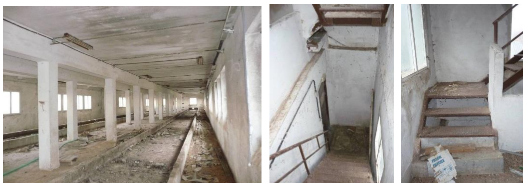
Vistas del gallinero en desuso
