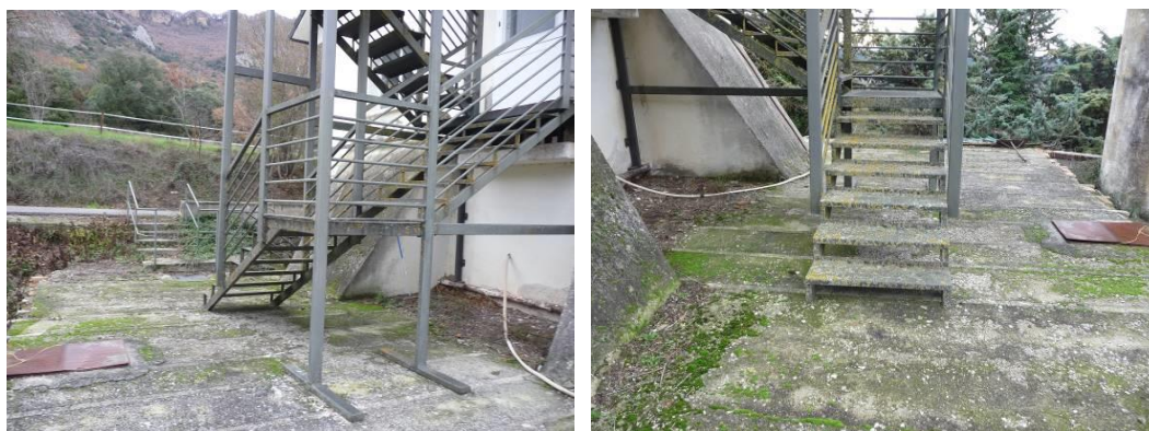
Vista de la fachada oeste y del depósito de purines
