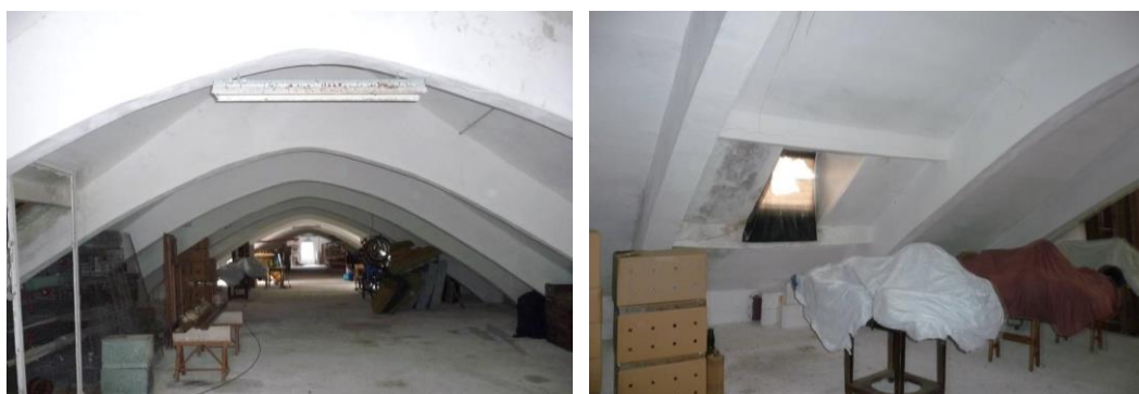
Vistas de la bajocubierta
