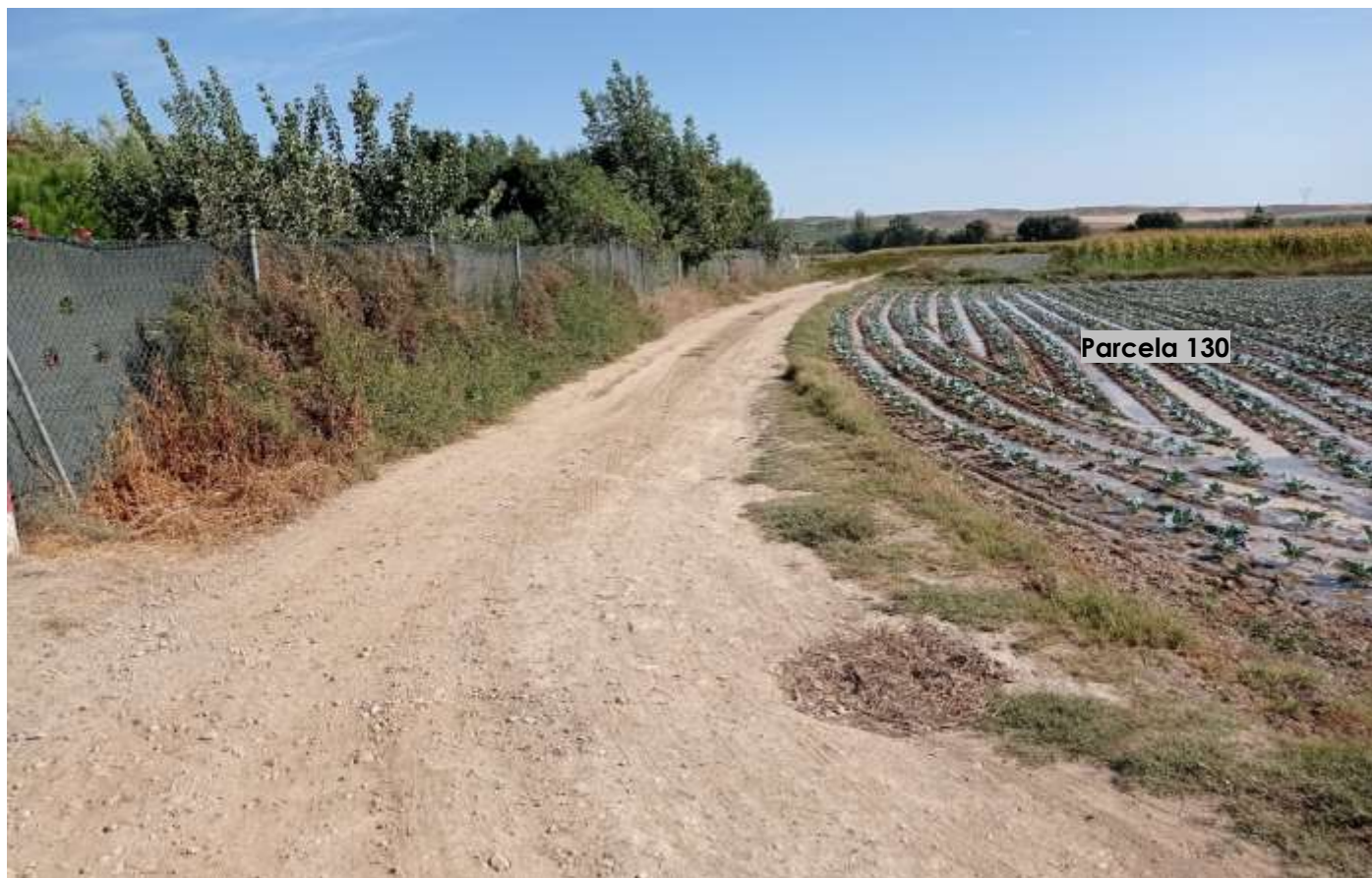
Vista general final TRAMO 3. Estrechamiento. Desbroce y afirmado.
