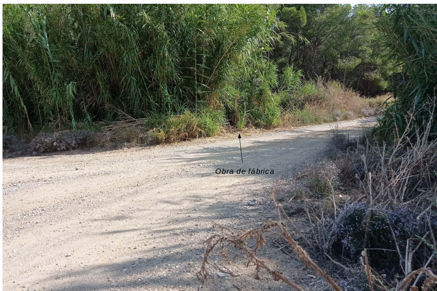
Vista general camino. Obra de fábrica
