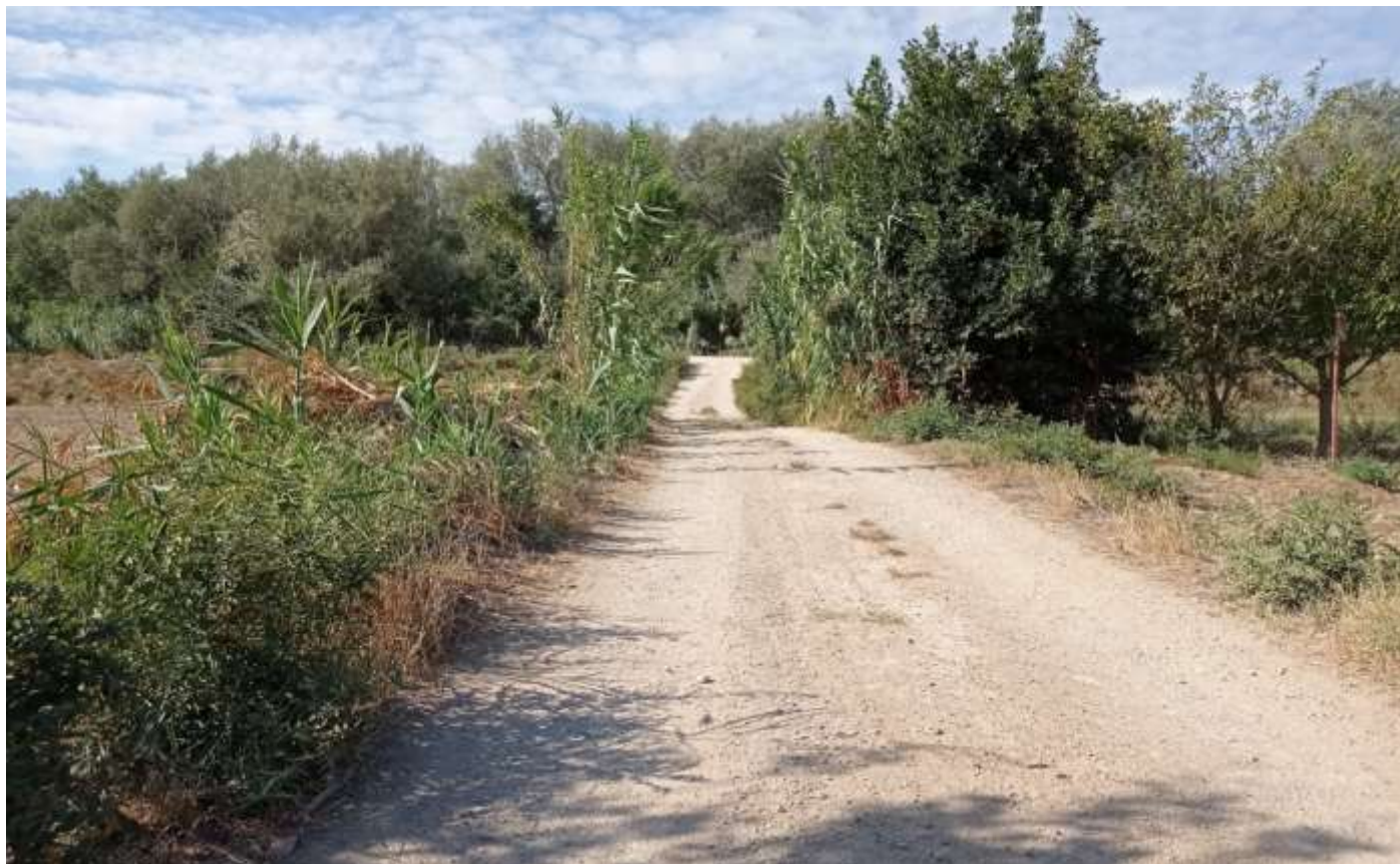
Vista general TRAMO 1. Desbroce de laterales, incluso cañas, ripado y zahorra artificial.
