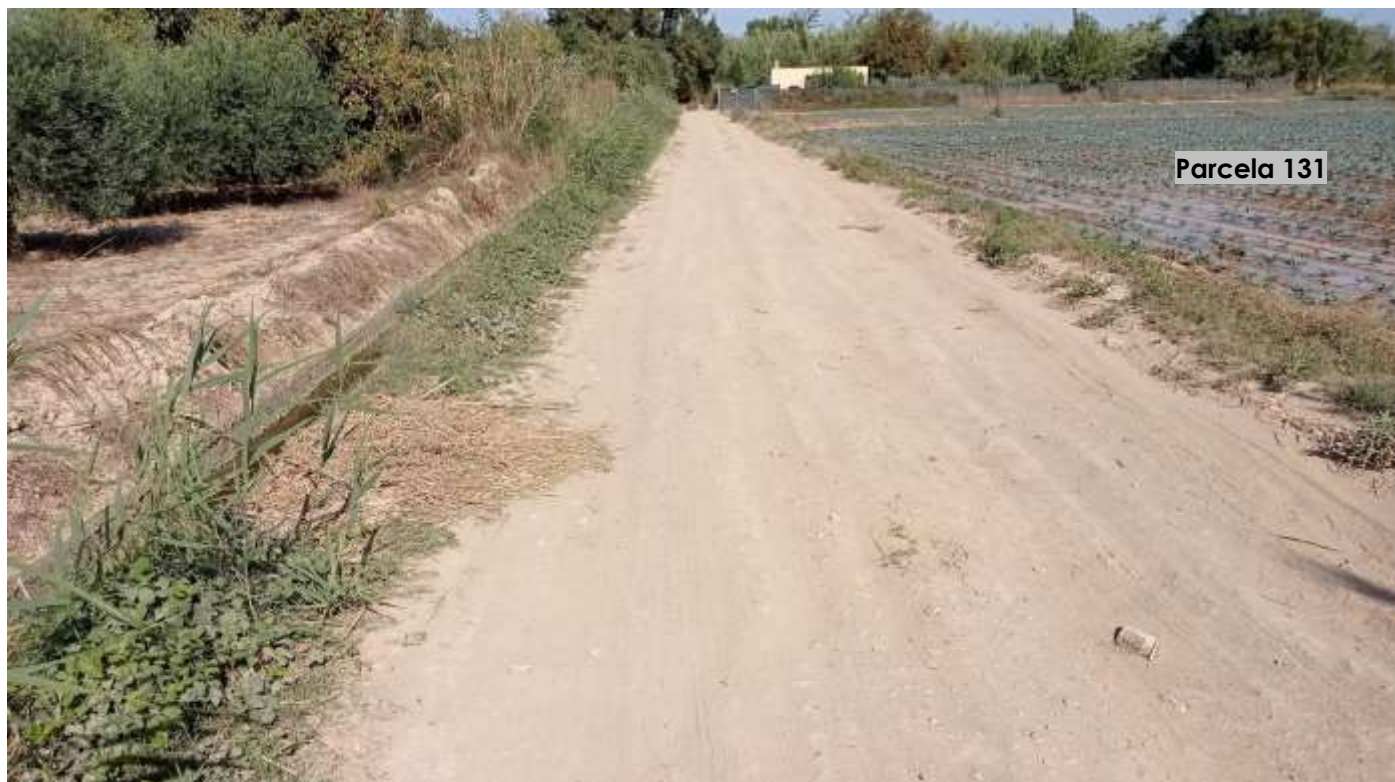
Vista general TRAMO 3. Ripado y extendido zahorra artificial.
