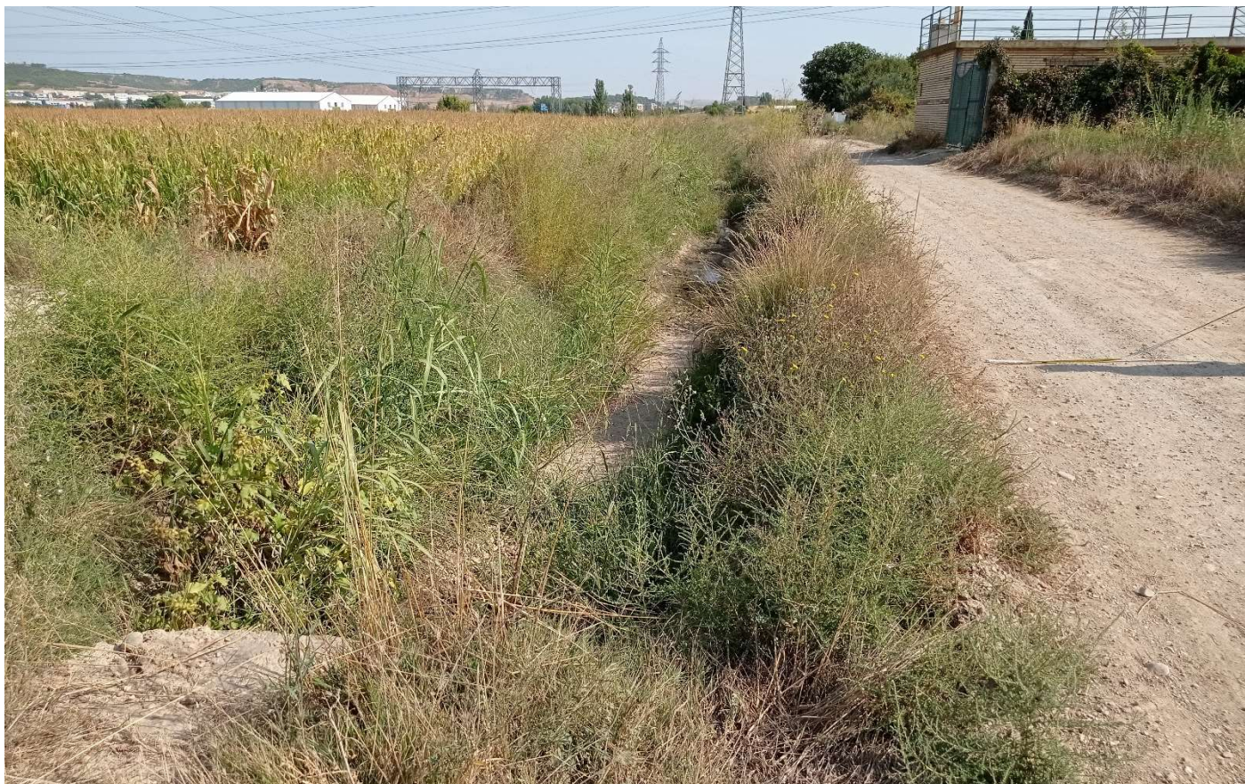
Detalle acequia en inicio actuación.
