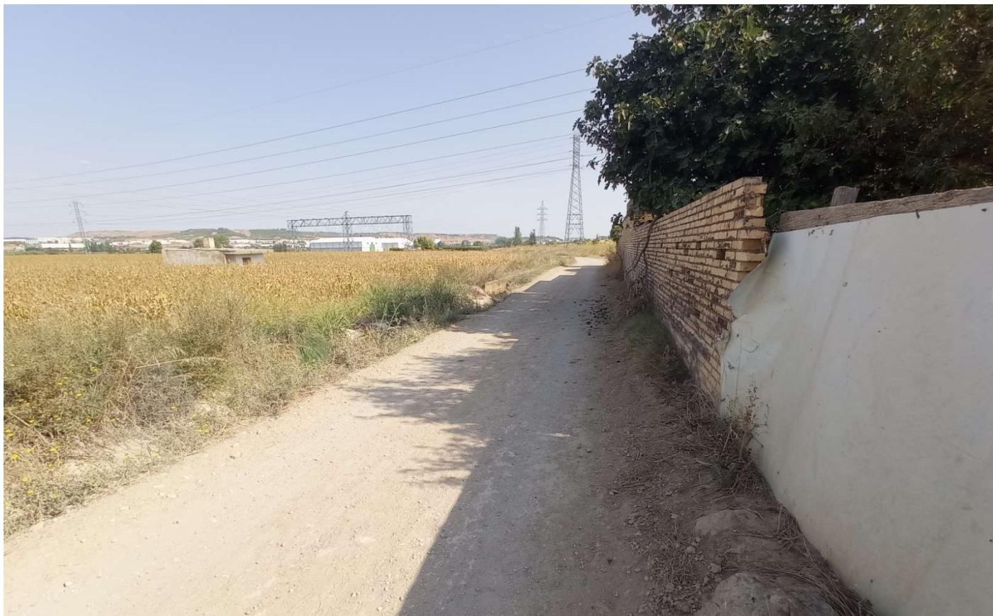
Vista general estrechamiento camino.
