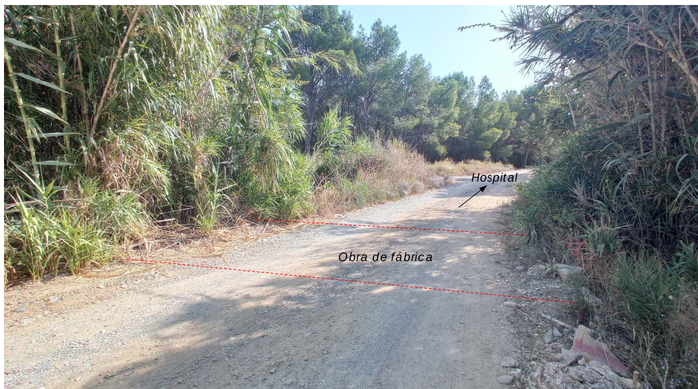
Vista general camino. Acceso al Hospital.
