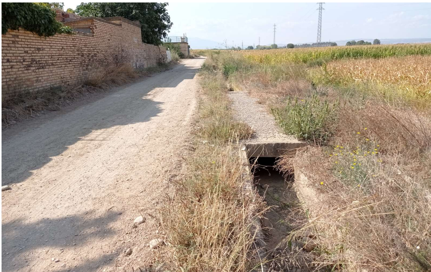
Vista general zona estrechamiento. Fin actuación: entronque con acequia existente.
