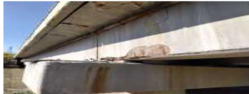
Foto_Vigas y riostras_5.png Fotos 29 viga 6 cargadero 2
