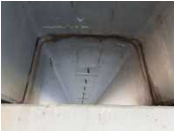
viga 2 y 3 sobre p2
