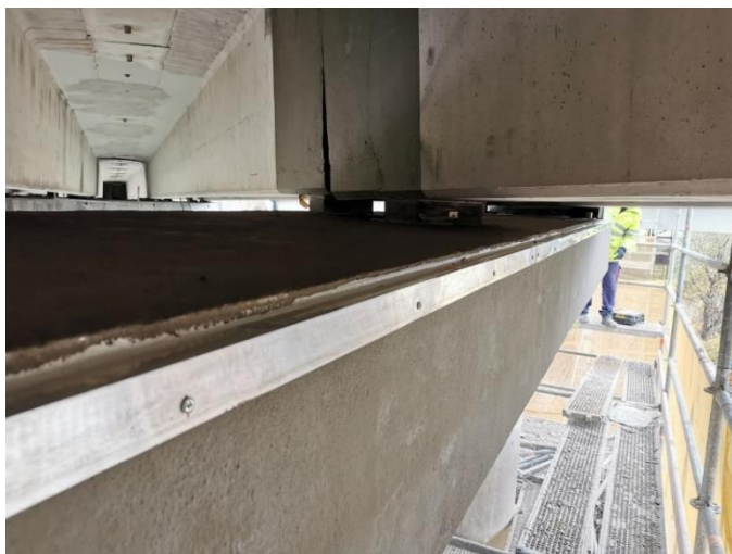
Cargadero y cabezas de viga terminadas con un tratamiento de membrana cementosa y vierteaguas
