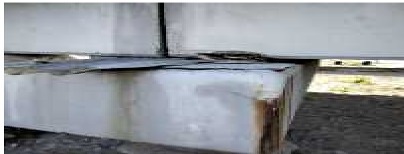
Foto_Vigas y riostras_7.png Foto 31 viga 1 cargadero 2
