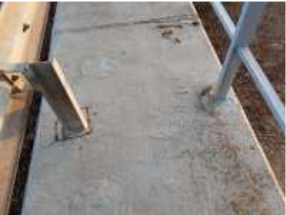
desprendimiento recubrimiento
