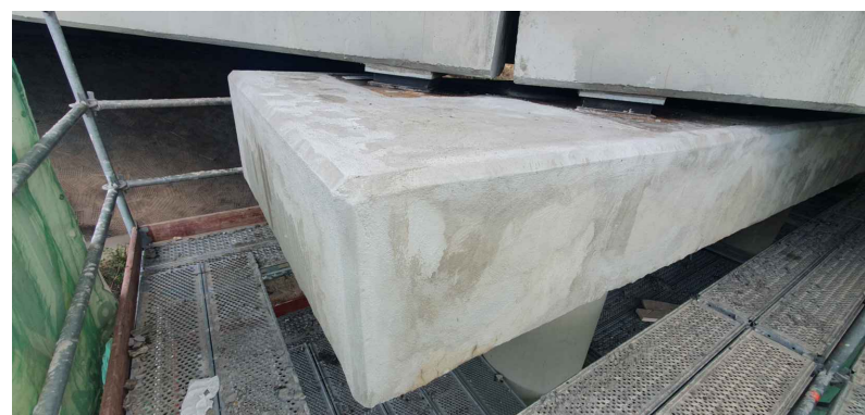
VIGAS Y DINTEL REPARADOS
