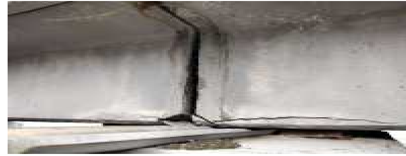
Foto_Vigas y riostras_5.png Foto 25 cargadero 1 vigas 6
