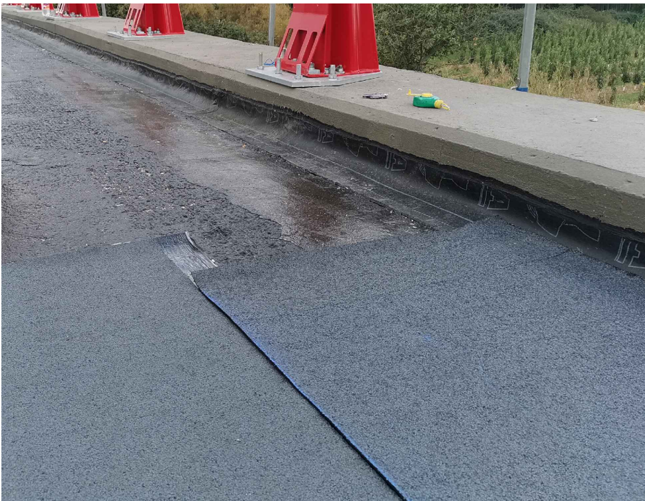
IMPERMEABILIZACION DEL TABLERO CON LÁMINA ASFÁTICA
