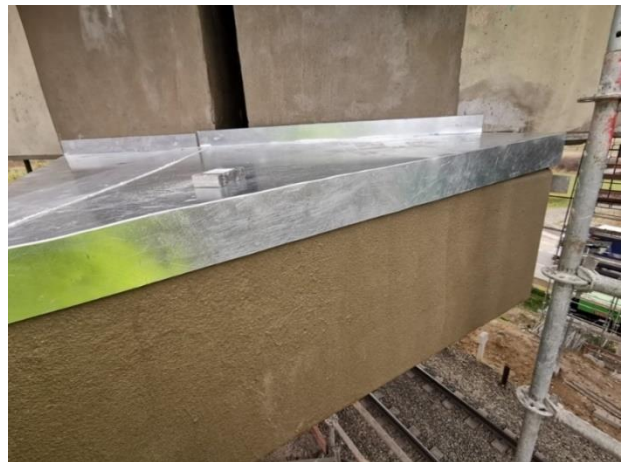
Aspecto de cargadero y cabezas de viga protegidas con membrana cementosa y superficie de cargadero protegido con faldón de chapa inoxidable
