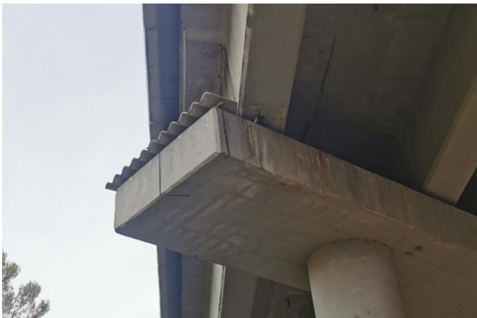
Aspecto de cargadero y cabezas de viga protegidas con membrana cementosa y superficie de cargadero protegido con faldón de chapa inoxidable
