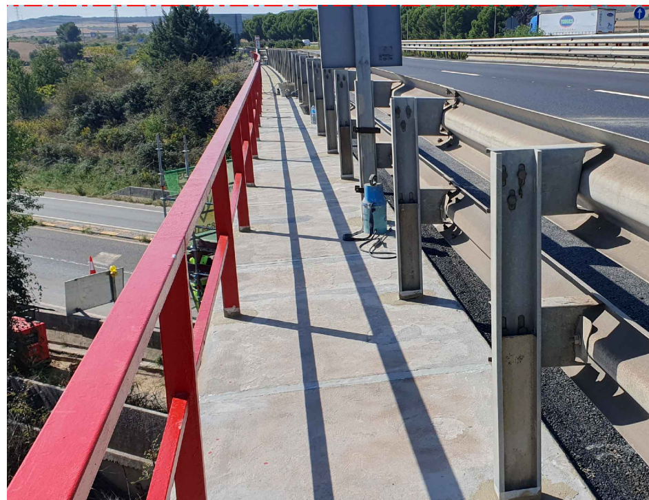
RECONSTRUCCIÓN DE LAS IMPOSTAS EN LA PARTE SUPERIOR
