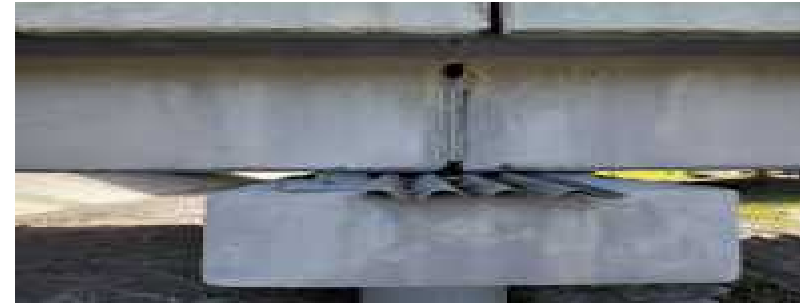
Foto_Vigas y riostras_3.png Foto 27 vigas 1 cargadero 1
