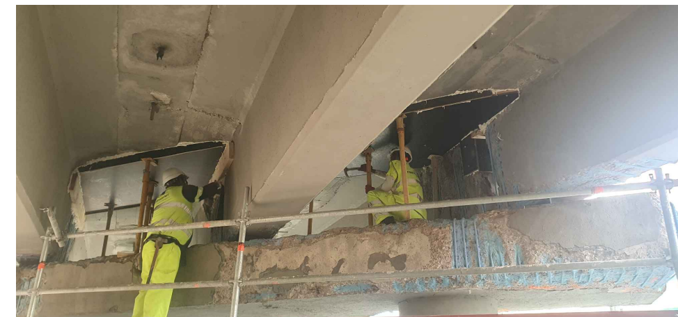
ENCOFRADO INFERIOR EN ZONA DE JUNTAS
