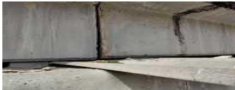
Foto_Vigas y riostras_9.png foto 29 vigas 1 sobre cargadero 2
