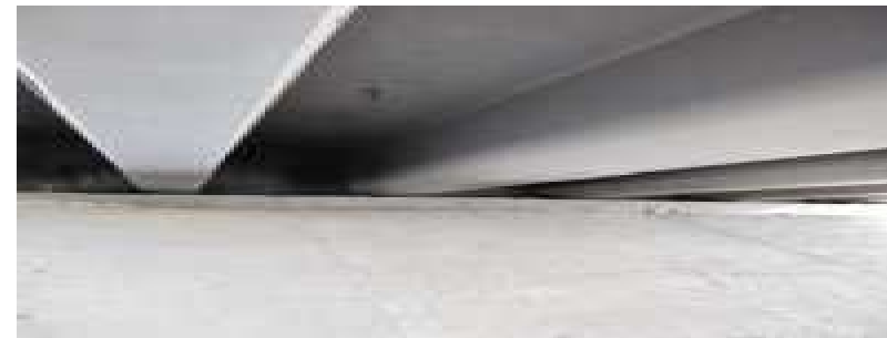
Foto_Estribos_2.png Foto 9 Estribo 2
