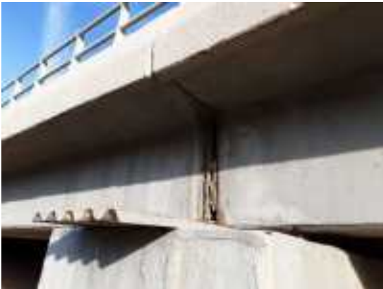
viga 6 sobre p2
