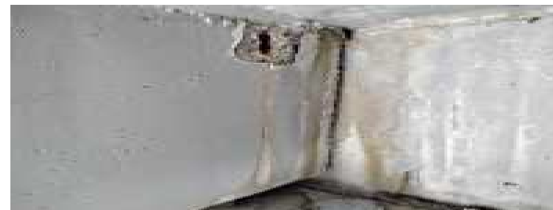
Foto_Vigas y riostras_2.png Foto 22 viga 1 estribo1
