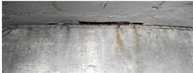
Foto_Losa_2.png Foto 36 unión espaldín losa estribo2
