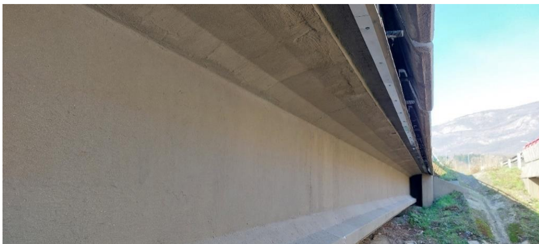
Viga de borde reparada y acabada con membrana cementosa y vierteaguas
