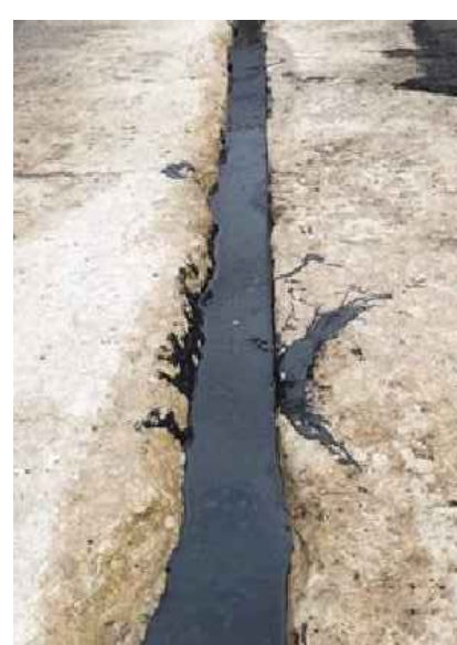
RECONSTRUCCIÓN DE ESTRUCTURAL LABIOS JUNTAS (SUPERIOR)
