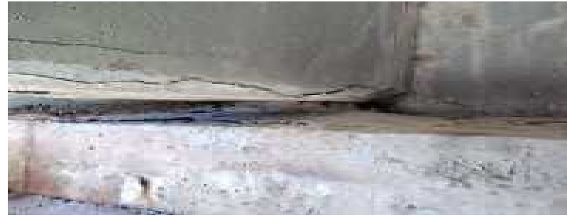
Foto_Estribos_6.png Foto 17 apoyo viga 6 estribo 2
