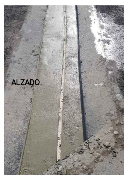
RECONSTRUCCIÓN DE ESTRUCTURAL LABIOS JUNTAS (SUPERIOR)
