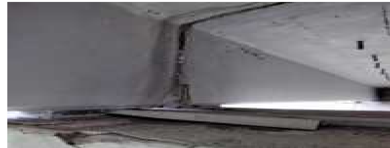
Foto_Vigas y riostras_8.png Foto 28 vigas 6 sobrecargadero 2
