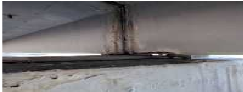
Foto_Vigas y riostras_4.png Foto 28 vigas 1 cargadero 1
