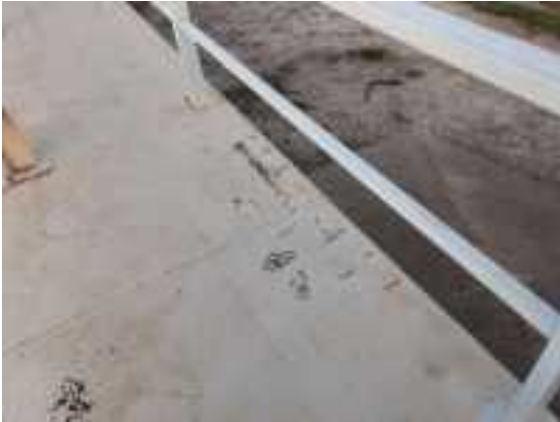
desprendimiento recubrimiento
