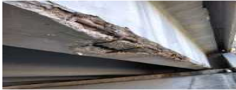
Foto_Vigas y riostras_11.png foto 35 viga 1 cerca de estribo 2
