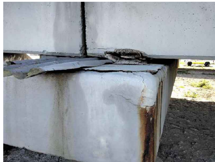
SITUACIÓN ACTUAL DE VIGAS Y DINTEL
