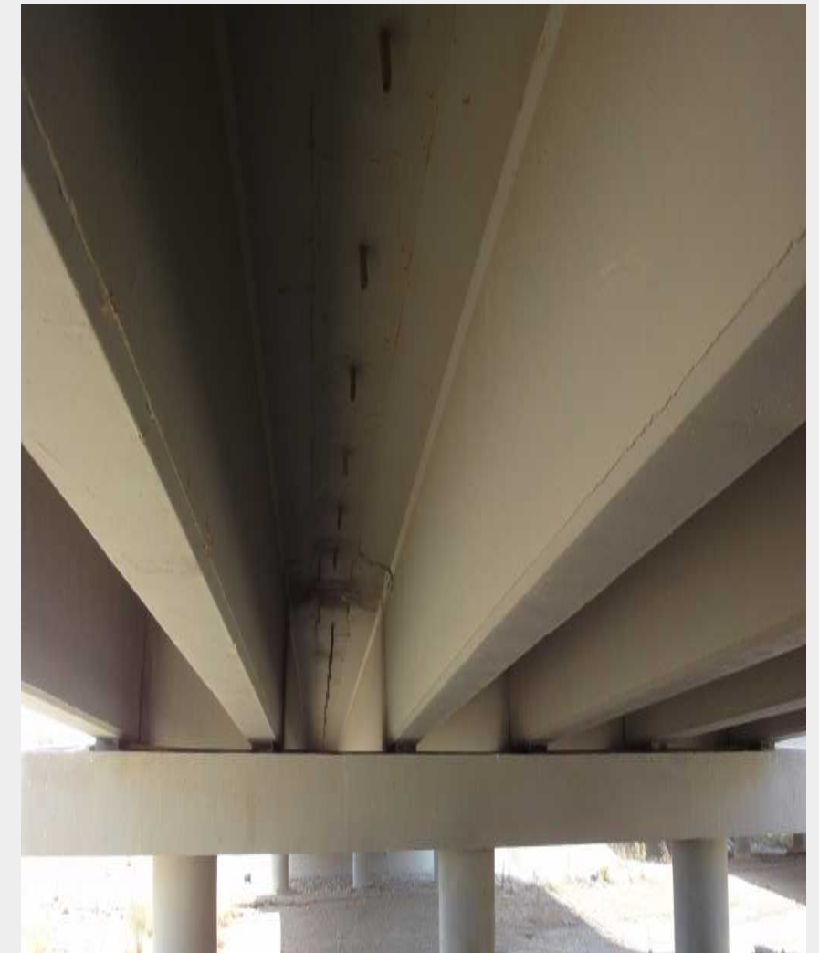
03-Vista inferior tablero
