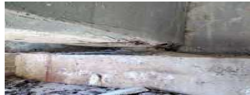
Foto_Vigas y riostras_9.png Foto 33 viga 6 estribo 1
