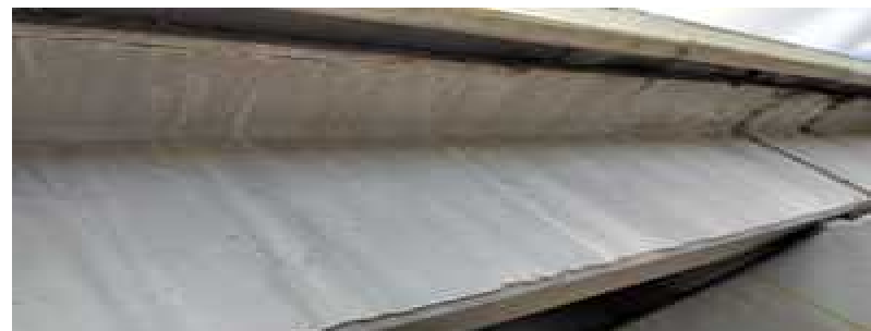
Foto_Vigas y riostras_1.png Foto 21 viga1
