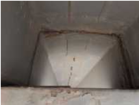
viga 1 y 2 sobre p1
