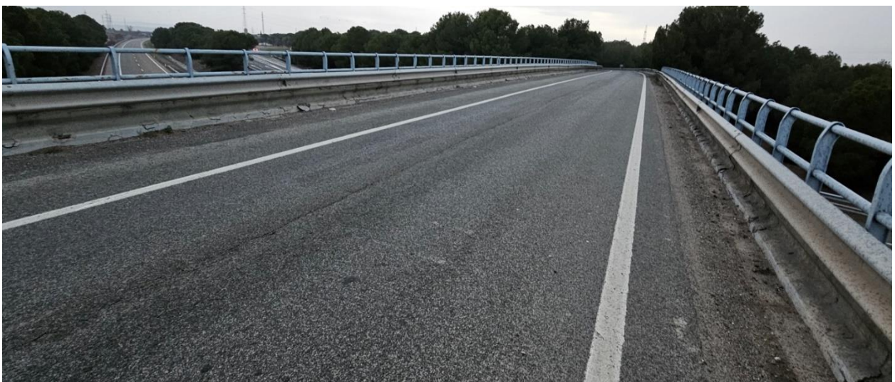
Foto del tablero paso superior del ramal de incorporación norte en el pk 6
