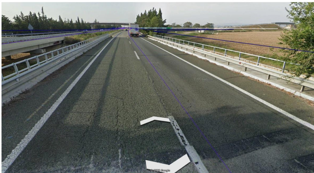
Foto del tablero paso inferior pk 31+900
