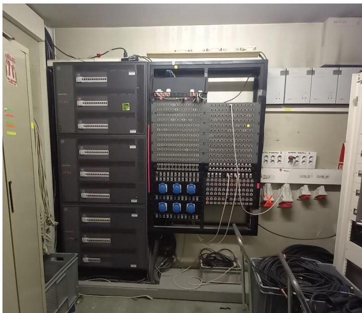
imagen del conjunto de dimmers y panel de patch
