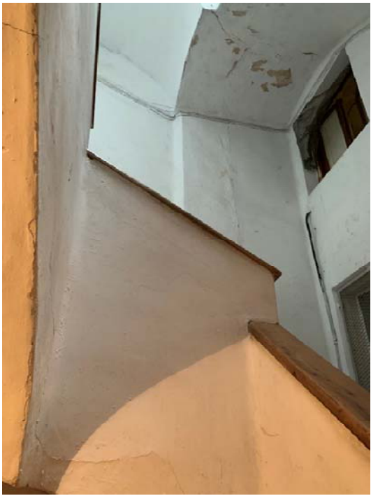
FOTOGRAFÍA 6: vista del interior de las escaleras.
