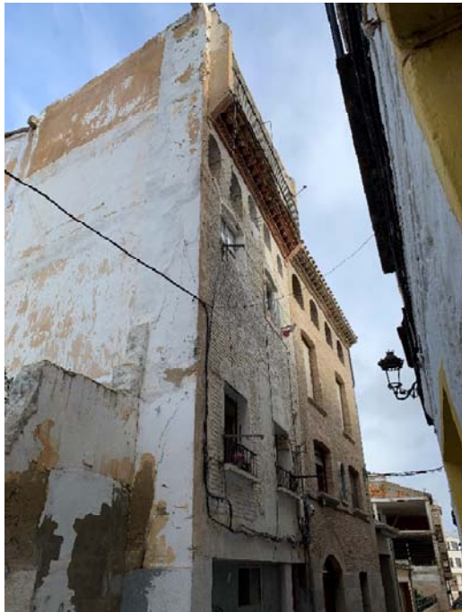
FOTOGRAFÍA 1: vista de parte de la fachada de la edificación desde C/ Dabán.
