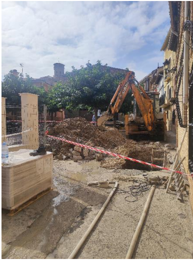
REPARACION DE DESPERFECTO Y FUGA EN COLECTOR DE SANEAMIENTO EN CALLE VERDE EN ENTRONQUE DE POZO DE REGISTRO FECHA REPARACION A 2 DE OCTUBRE DE 2023
