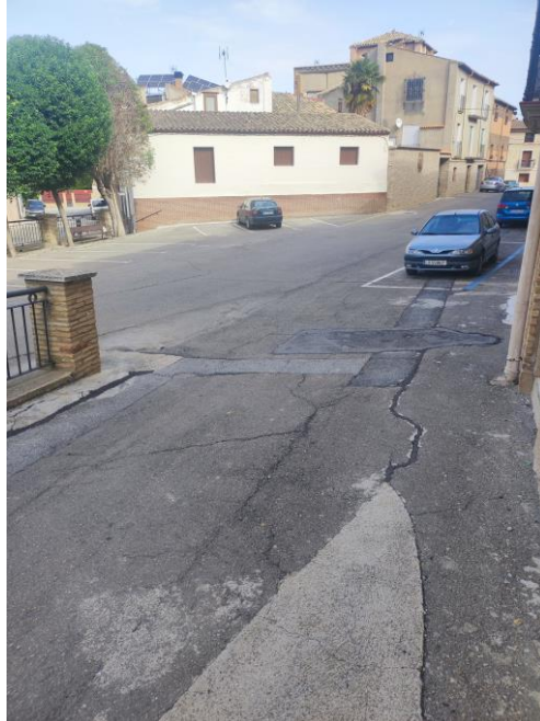
INICIO CALLE MURO INTERSECCION CON CALLE MESON
