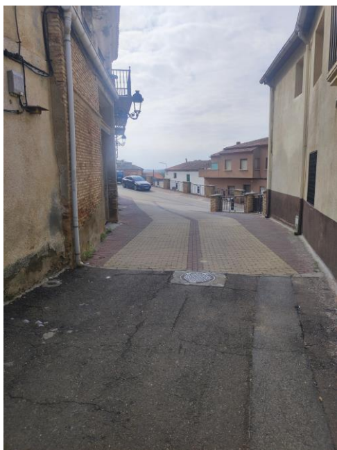
FINAL DE CALLE MURO INTERSECCION CON PLAZA NUEVA
