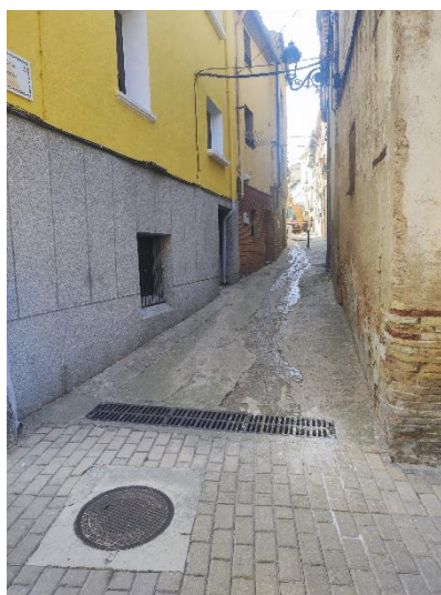
INICIO DE CALLE VERDE DESDE CALLE MAYOR
