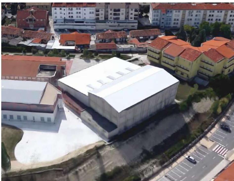
Fotografía 2: Vista aérea del frontón y sala polideportiva. Anexos a ellos los 2 módulos con vestuarios.
