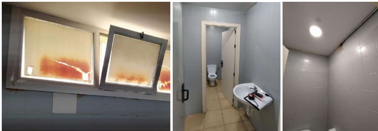
Fotografía 14: Carpinterías y aseos
