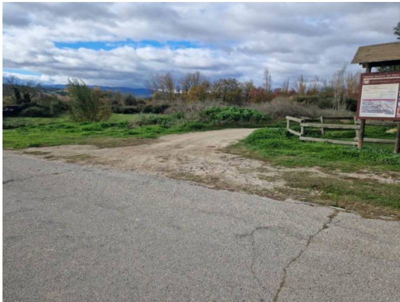
Cruce entre carretera del Ramillo y camino
