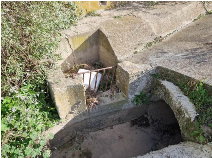
Punto de conexión 01 de acequia con paso por debajo de calle Bajada a la Barca.
