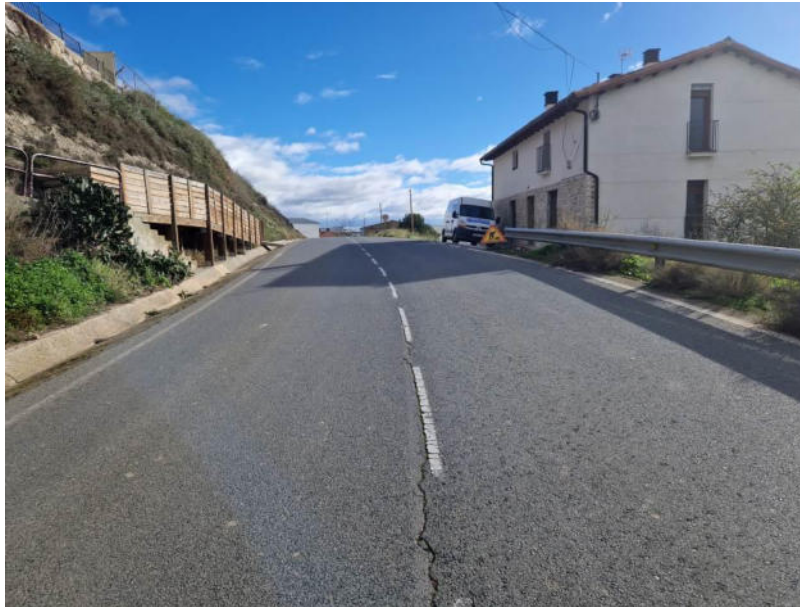
Fin de zona de actuación
