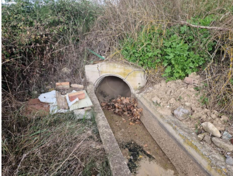
Punto de conexión 02 de acequia con paso por debajo de calle Bajada a la Barca.
