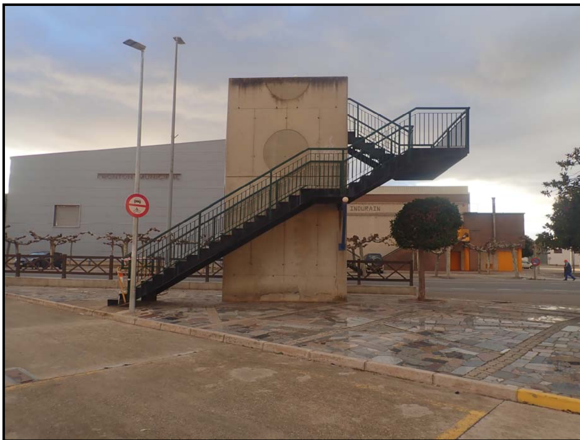
ESCALERA DE ACCESO ESTE
