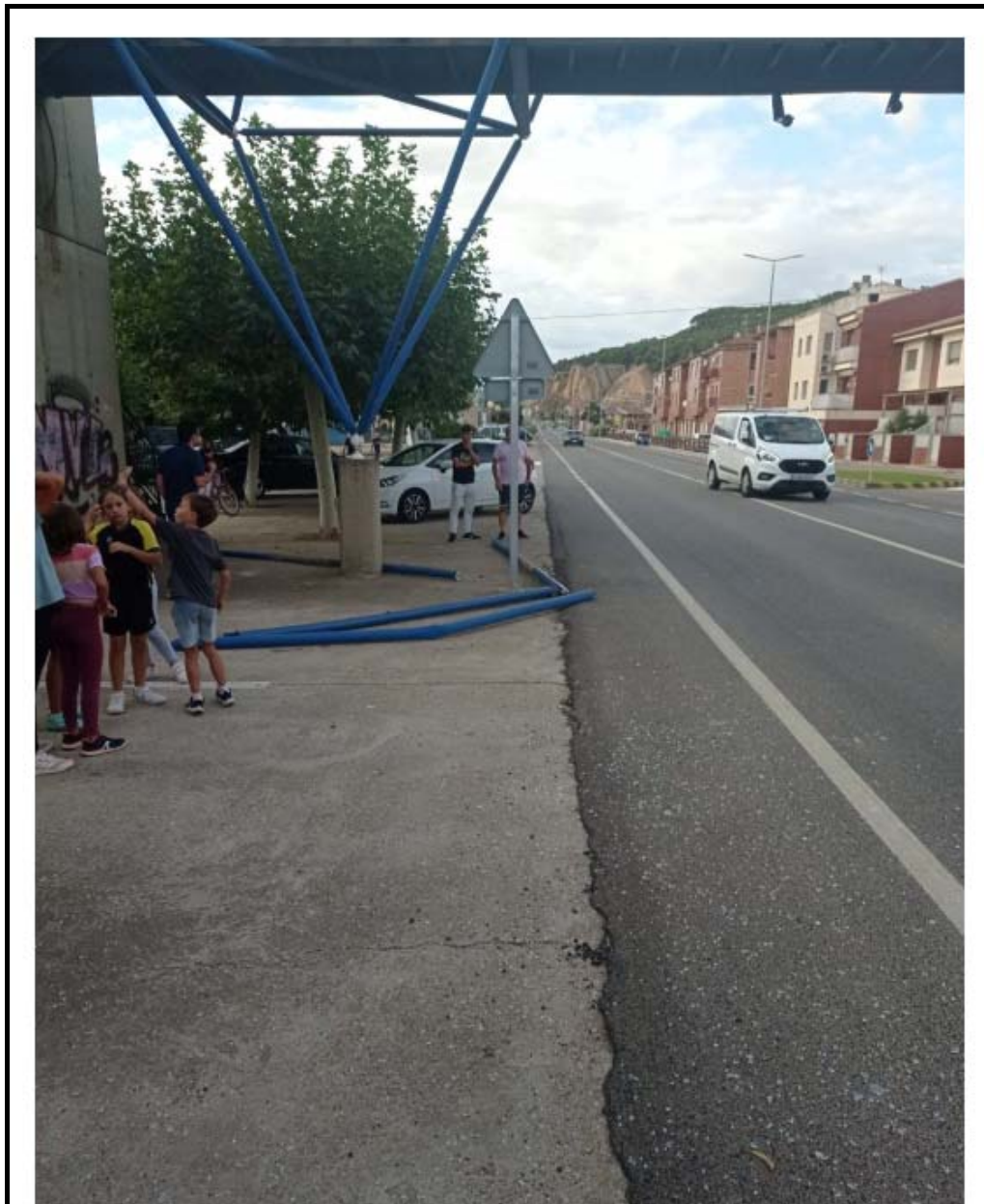
DETALLE BARRAS CAIDAS APOYO OESTE
