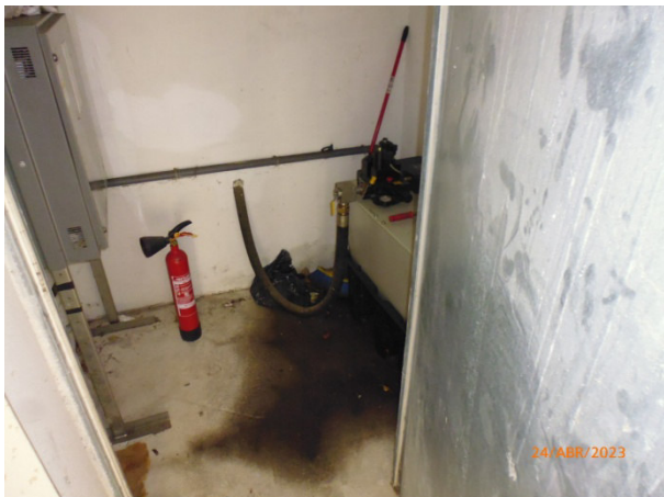
Cuarto de ascensores
