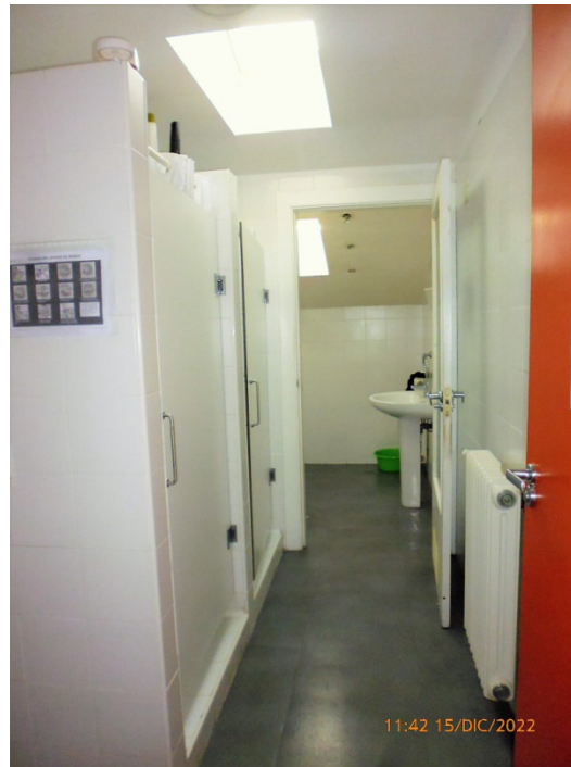
Baño entrecubierta (estado actual)
