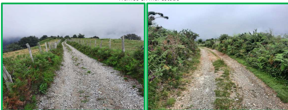
Tramos en mal estado
