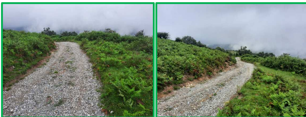
Estado actual de la pista
