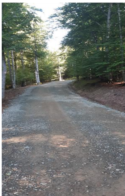
Subbase y capa de rodadura con ofita
