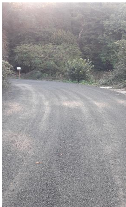
Subbase y capa de rodadura con ofita
