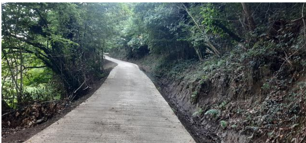
Pavimento de HA
