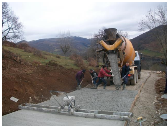
Hormigonera traccionada para transporte y extendido de hormigón, y regla vibrante para vibrar el hormigón
