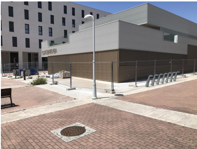
Punto de instalación
