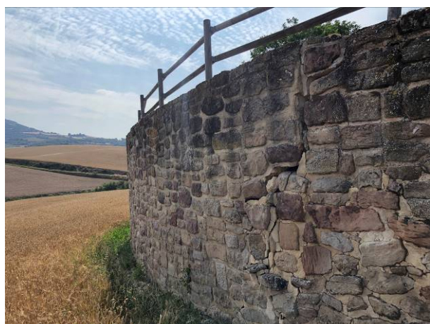
Foto 11: Muro acceso cementerio
