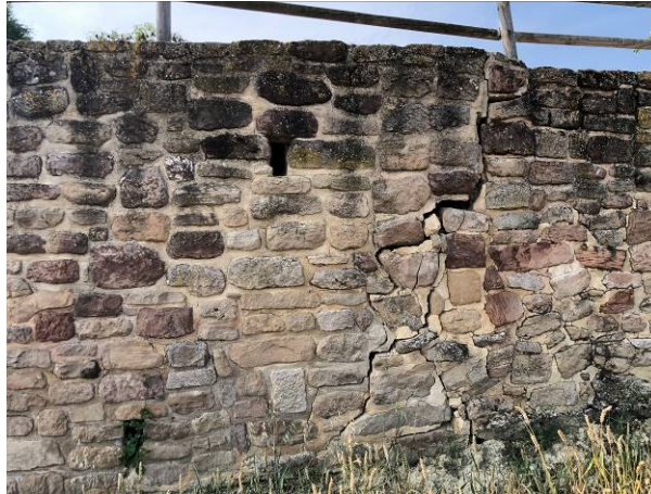
Foto 13: Muro acceso cementerio
