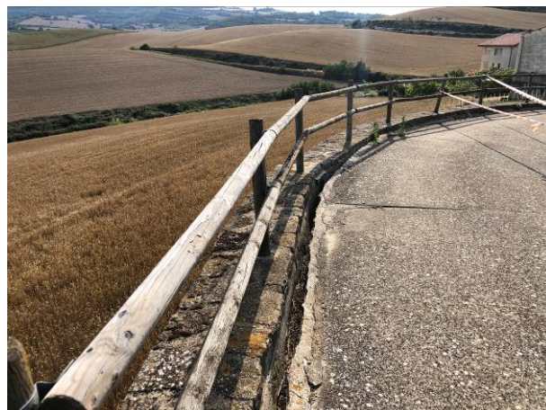
Foto 8: Muro acceso cementerio
