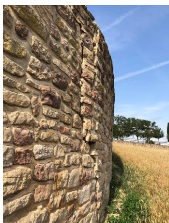
Foto 9: Muro acceso cementerio
