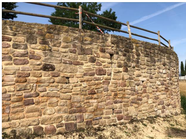
Foto 7: Muro acceso cementerio
