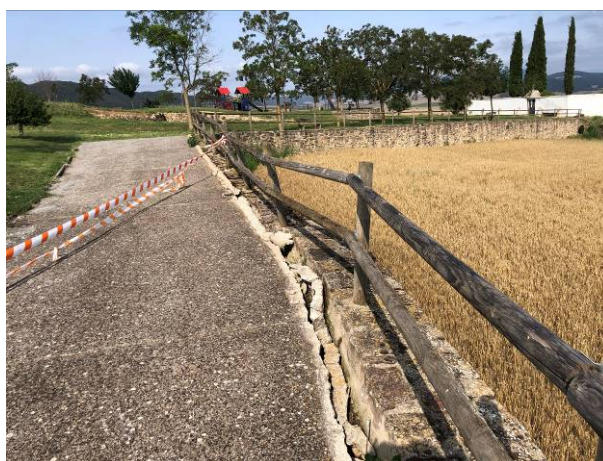
Foto 6: Muro acceso cementerio
