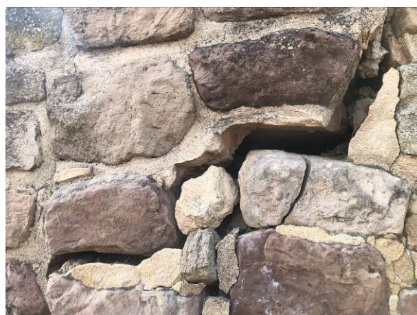
Foto 12: Muro acceso cementerio
