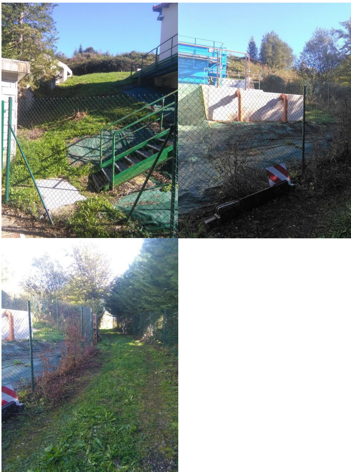
Vistas generales de la ETAP y zona donde se realizaron los ensayos
