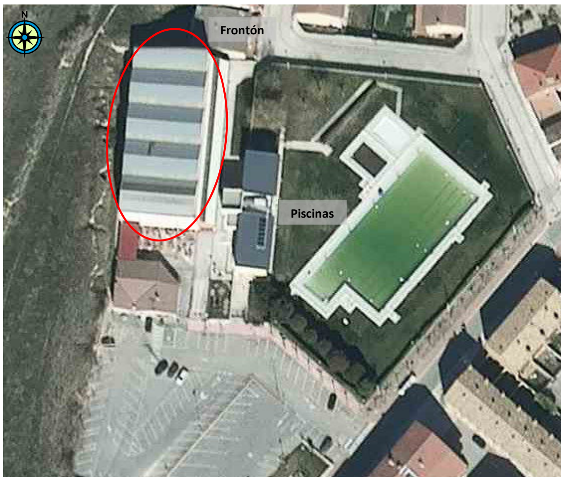
Instalaciones Deportivas Municipales - Arróniz
