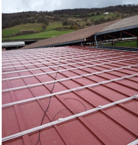
Cubierta Inclinada Metálica
