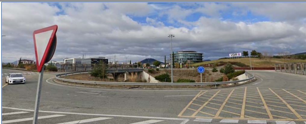
1. Glorieta sobre PA-30
