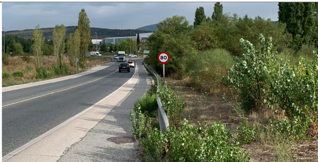
7. Vista general de la margen
