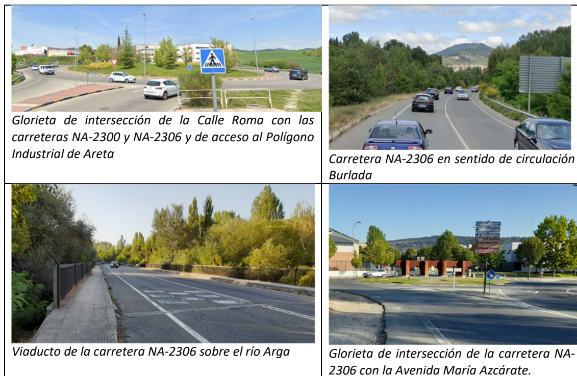
Figura nº 7: Fotografías tramo nº 4, Carretera NA-2306.
