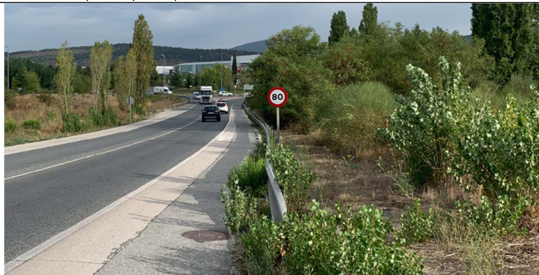
Margen derecha de la carretera NA-2300
