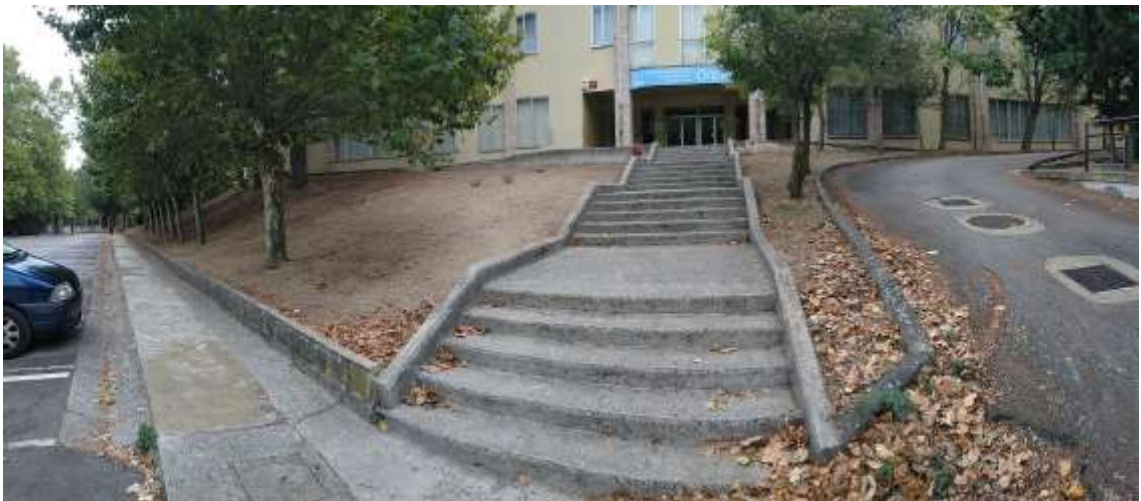
Zona delantera donde se proyectan los muros, con una altura que varía entre aproximadamente los 3 y 7 metros de altura.
