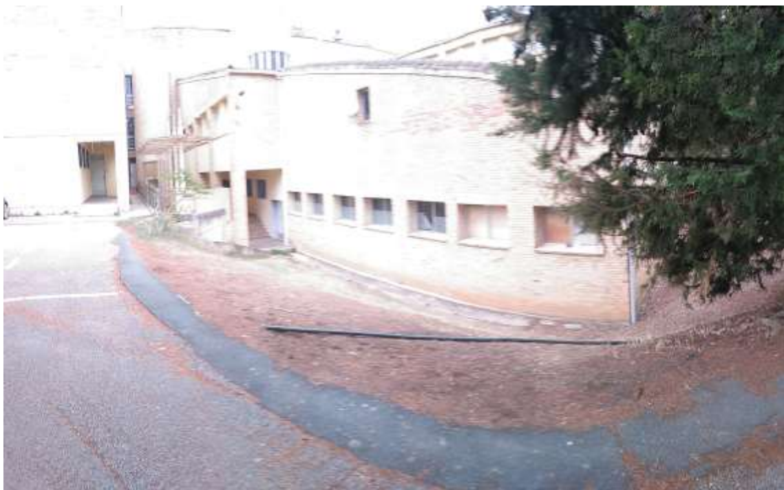
Zona de acceso al DPSH 3, donde no se puede acceder con la maquinaria. Se observa la diferencia de cota entre los viales circundantes, donde se realizaron los sondeos y DPSH y el suelo de planta baja, de unos 2,5 metros.
