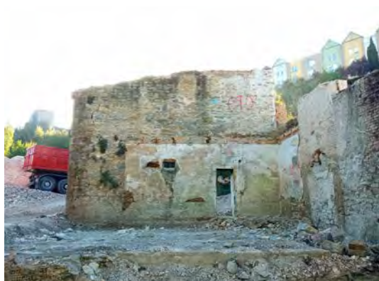
Alzado del paramento y detalle de los sillarejos que lo conforman
