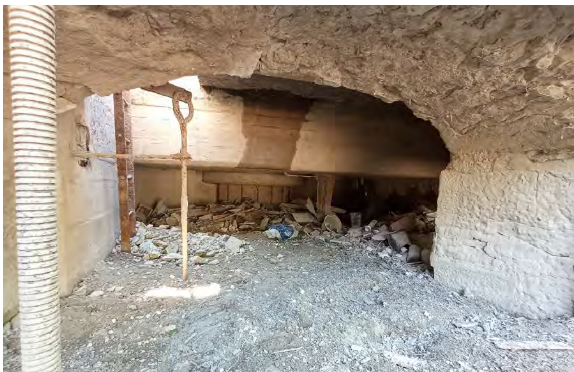
Detalle de la estructura de hormigón
