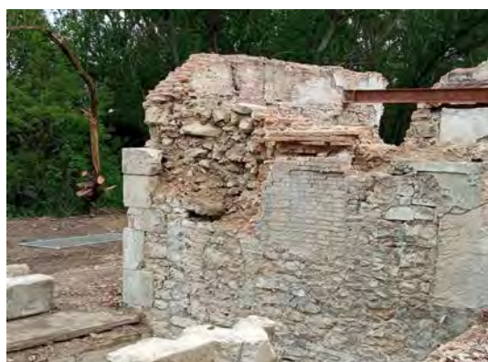
Detalles del desprendimiento de la camisa del muro, exterior e interior
