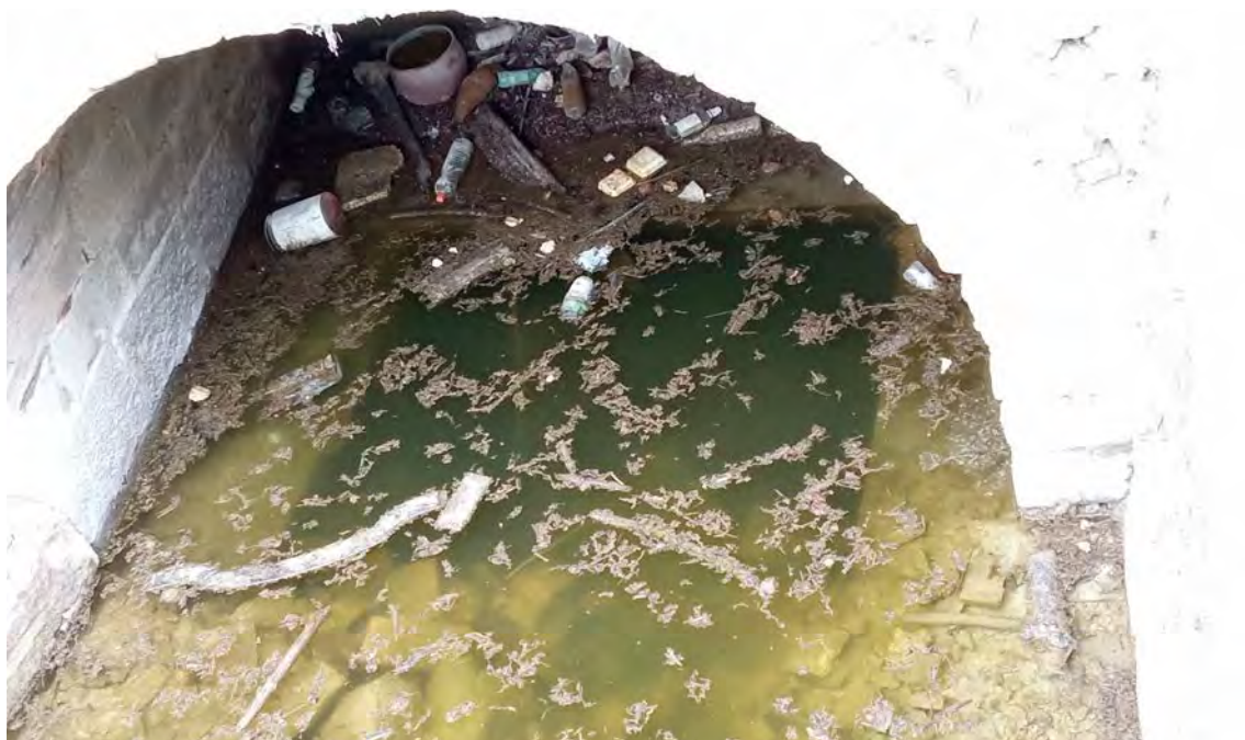
Detalle de la construcción bajo el arco del socaz
