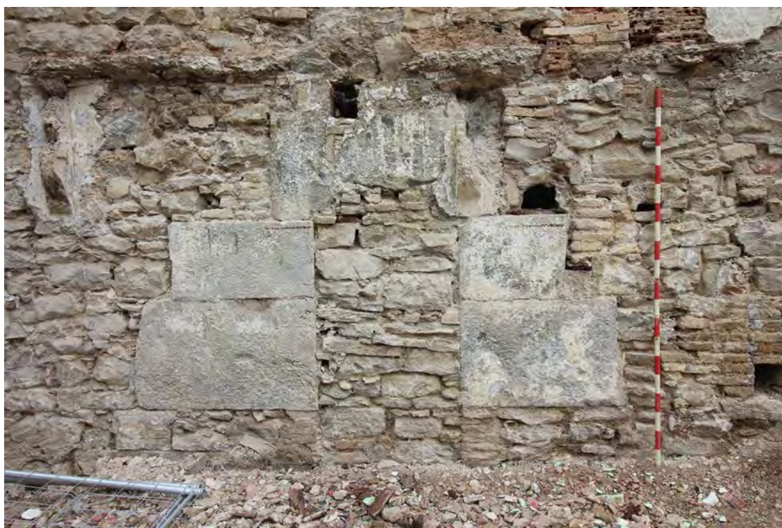
Ejemplo de la sillería de un vano sellado de la pared oeste, sobre sillarejos
