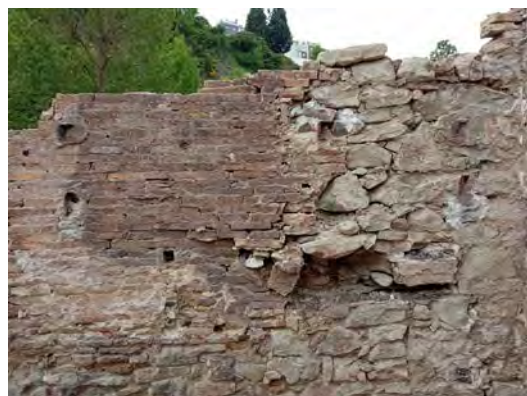
Detalles del desprendimiento de la camisa del muro, exterior e interior
