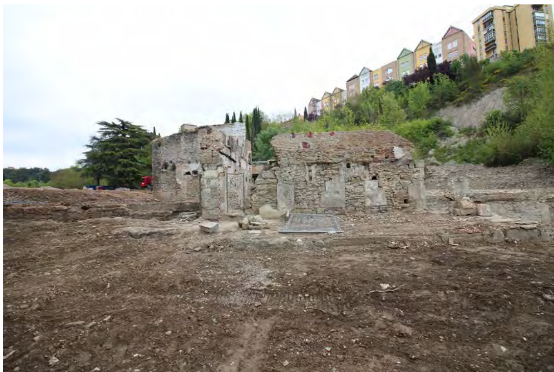
Vista del lado oeste del molino una vez realizados todos los derribos
