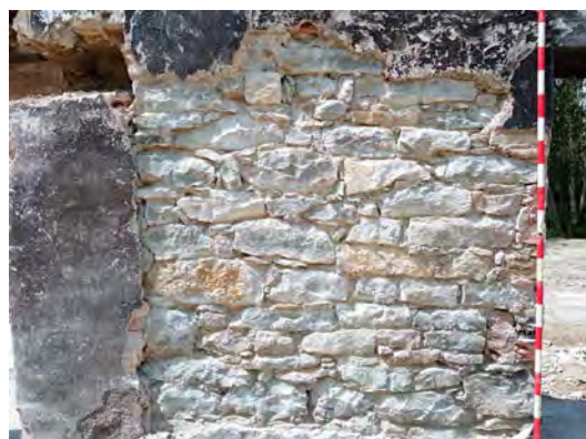
Alzado del paramento y detalle de los sillarejos que lo conforman
