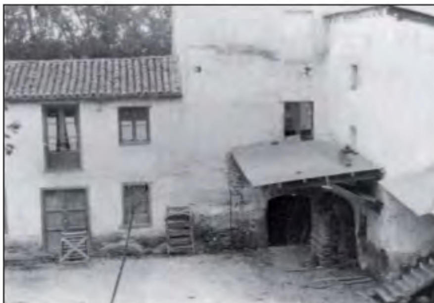
Imagen de la harinera de Ilundain 2 , paramento este
