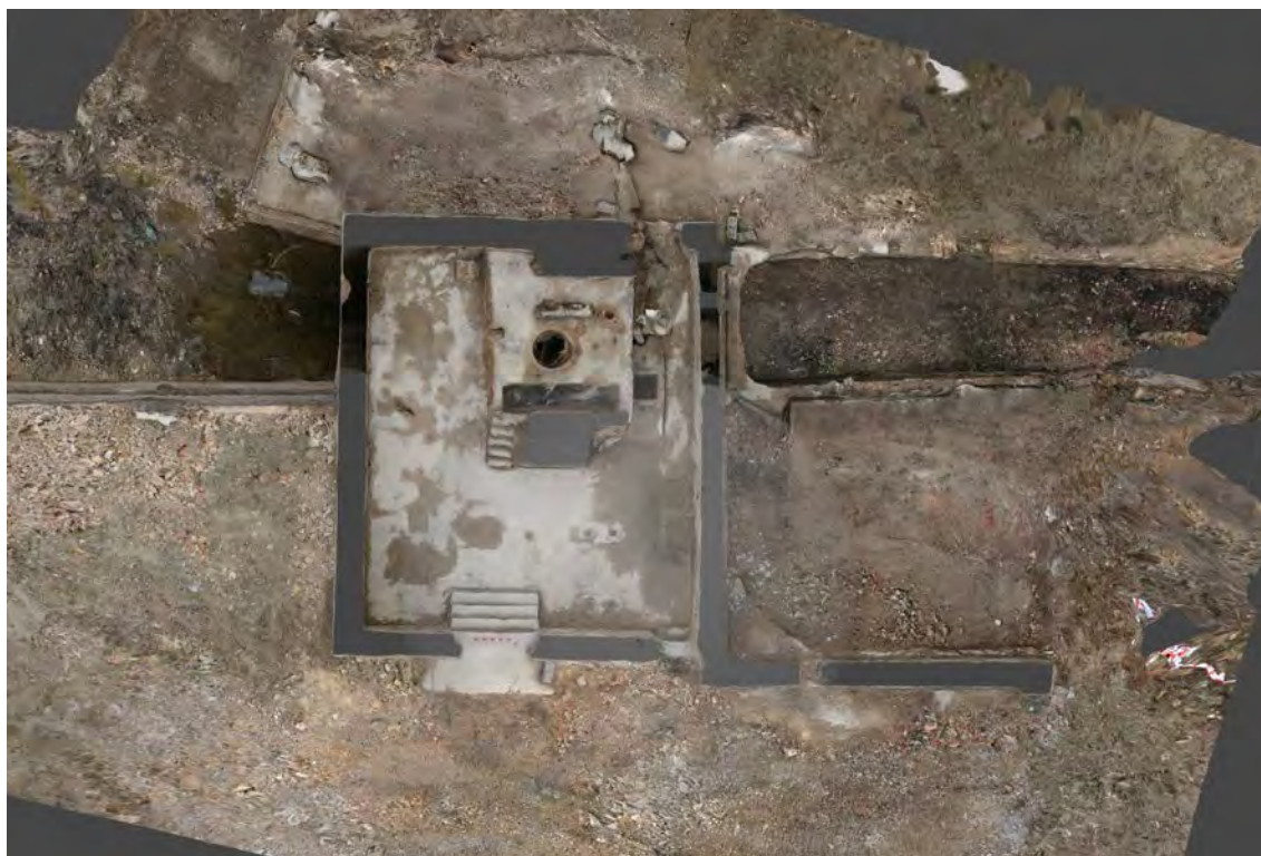
Planta de los restos preservados de la demolición, extraída de la fotogrametría
