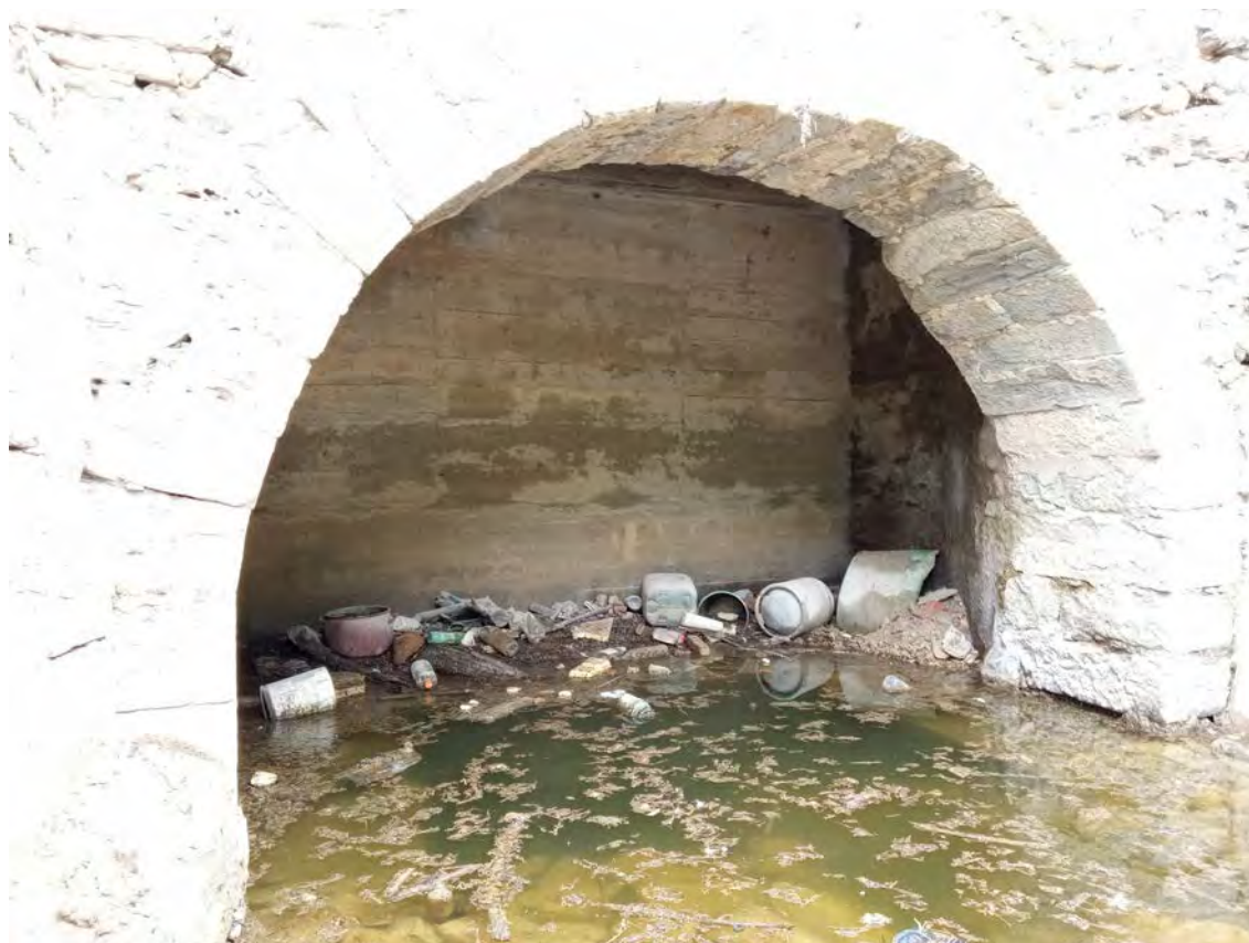
Detalle de la estructura de hormigón interior del molino, desde el socaz
