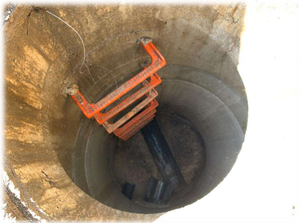
Fotografía 11 –Detalle pozo de registro de saneamiento, entronque calle La Bodega con Travesía de Lerín.
