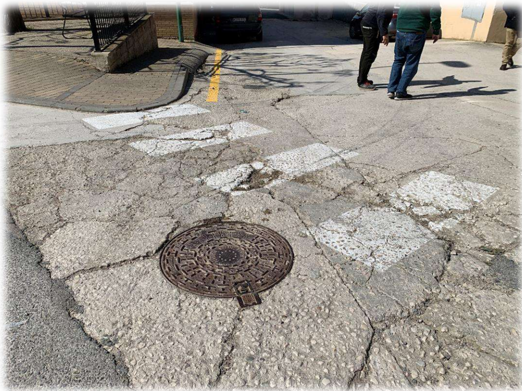
Fotografía 1 – Entronque carretera Berbinzana con la calle la Bodega, arqueta de Abastecimiento.
