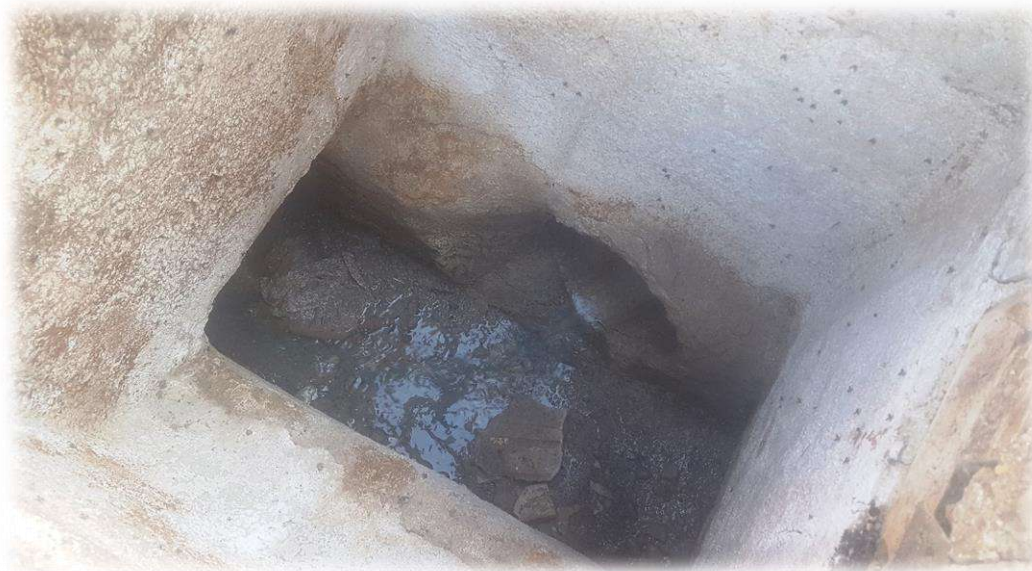
Fotografía 7 – Cambio de colector de Saneamiento a canal.
