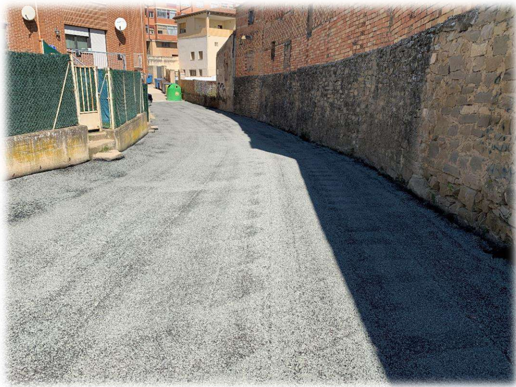
Fotografía 9 – Vista general calle La Bodega.
