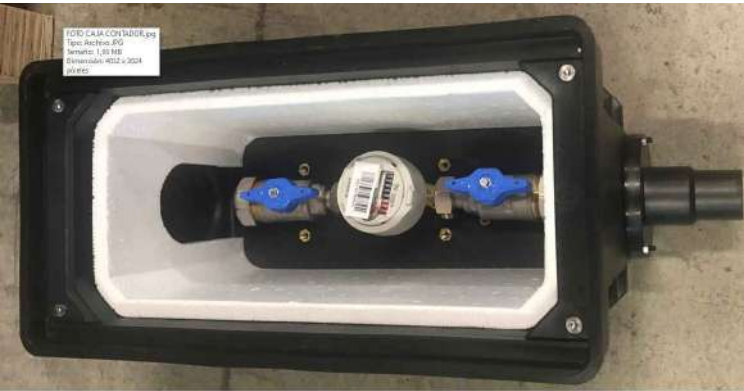
FOTO DEL MONTAJE CAJÓN CONTADOR
