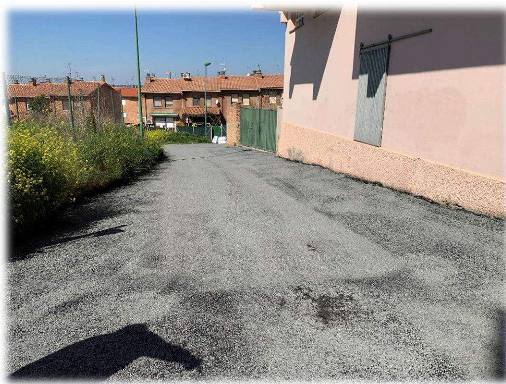
Fotografía 8 – Vista general calle La Bodega.
