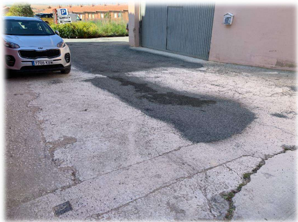
Fotografía 6 – Vista calle La Bodega.
