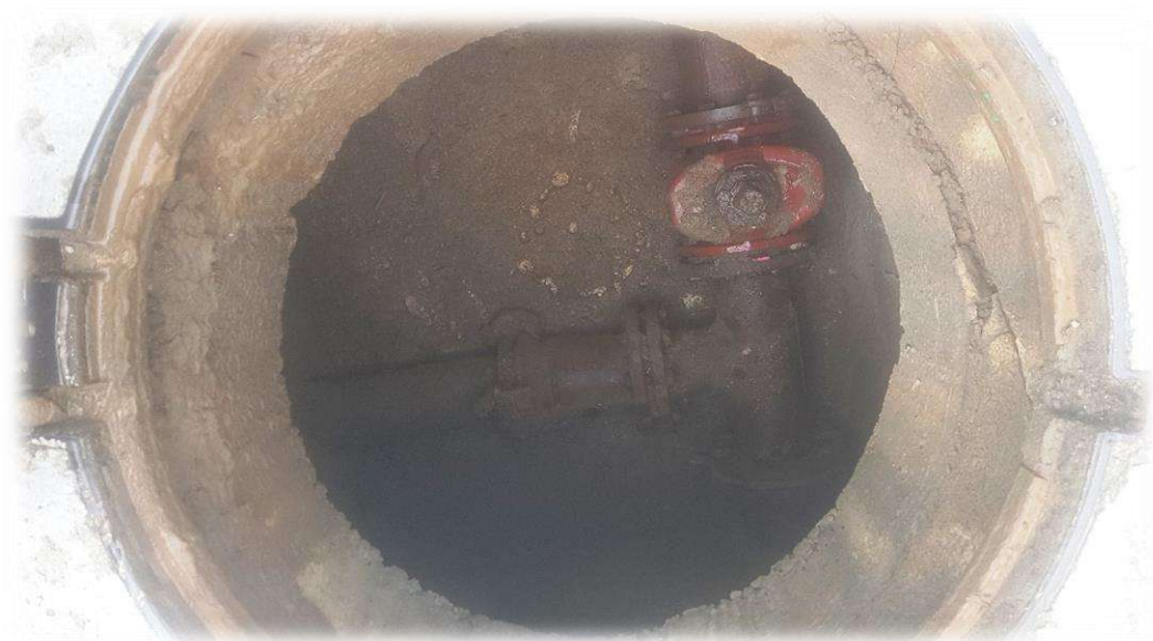
Fotografía 15 – Detalle del nudo de abastecimiento en el entronque calle La Bodega y carretera Lerín.
