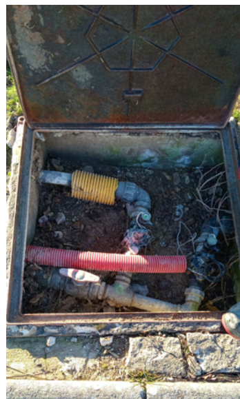
Fig.13: fotografías de dos arquetas de la red actual de riego existente, con el mismo tipo y distribución de las piezas, conexiones, fabricación de la arqueta y tapa, que las arquetas de proyecto.
