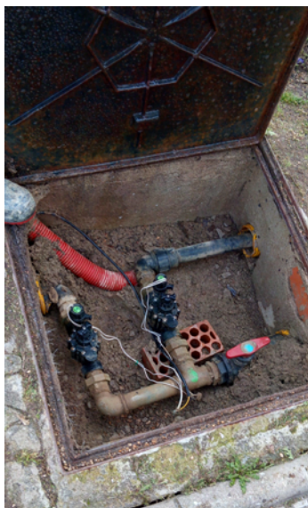
Fig.13: fotografías de dos arquetas de la red actual de riego existente, con el mismo tipo y distribución de las piezas, conexiones, fabricación de la arqueta y tapa, que las arquetas de proyecto.
