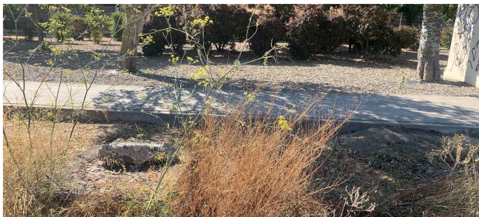
Registro de saneamiento al sur de la parcela
