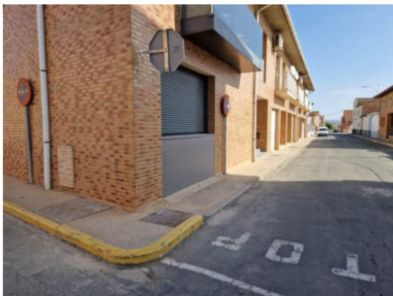
Detalle Arqueta H y pedestal en fachada.
