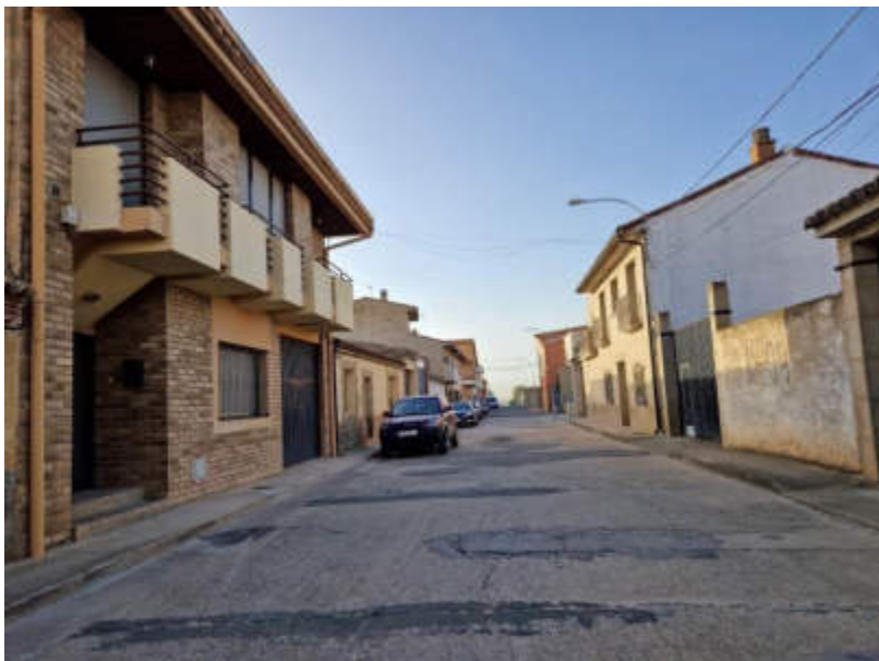
Firme de hormigón en tramo inicial con parches en aglomerado asfáltico.
