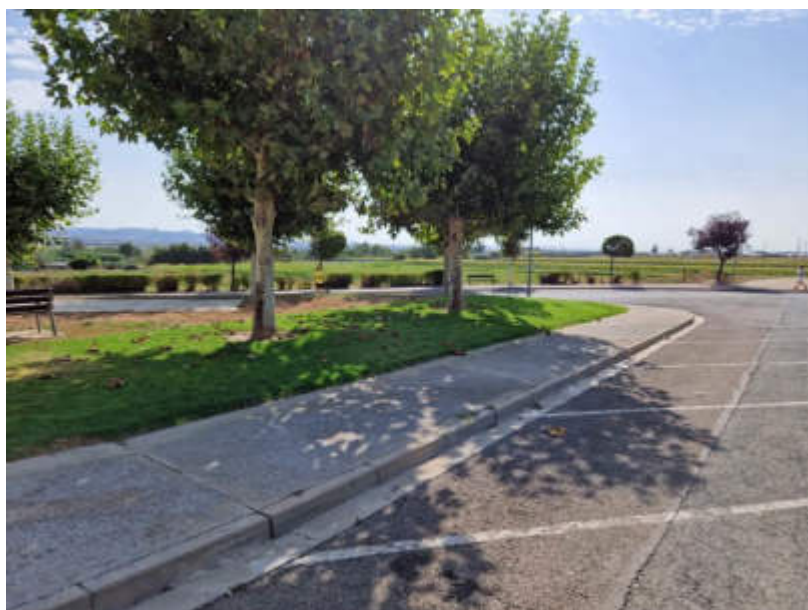
Tramo final de la actuación
