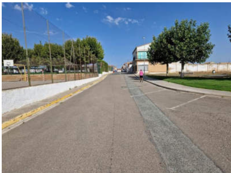
Tramo zona piscinas municipales con pavimento asfáltico
