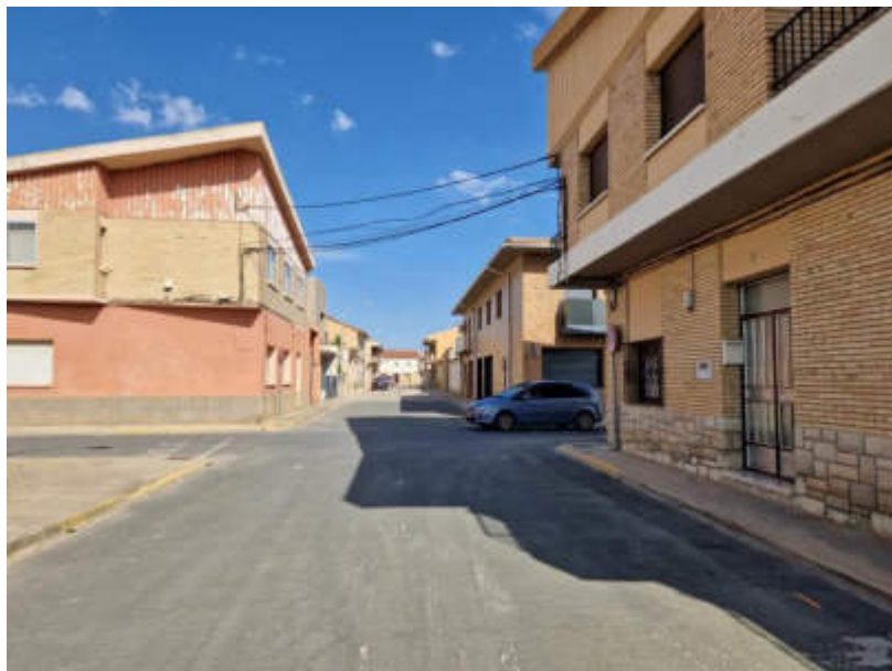
Cruce con calle San José (Pavimento asfáltico)
