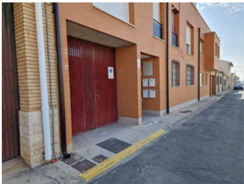
Detalle zona de arquetas de telecomunicaciones e I-DE
