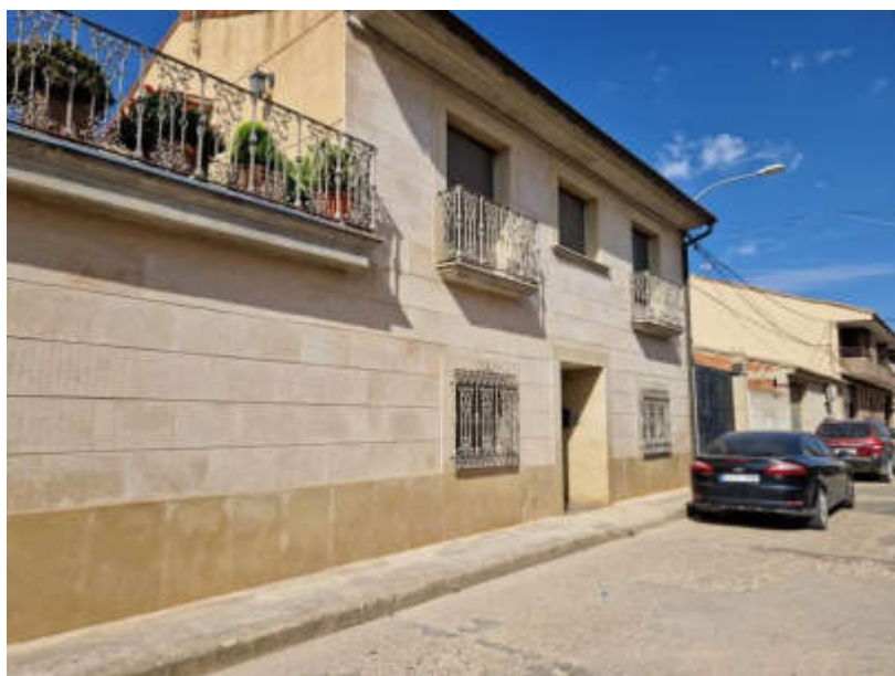
Detalle alumbrado sobre fachada
