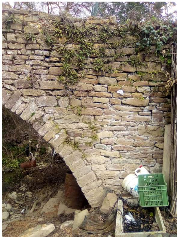
Estribo septentrional aguas arriba
