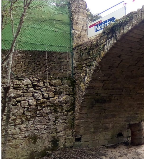
Estribo septentrional aguas abajo, adosado a parcela con muro de contención de terreno
