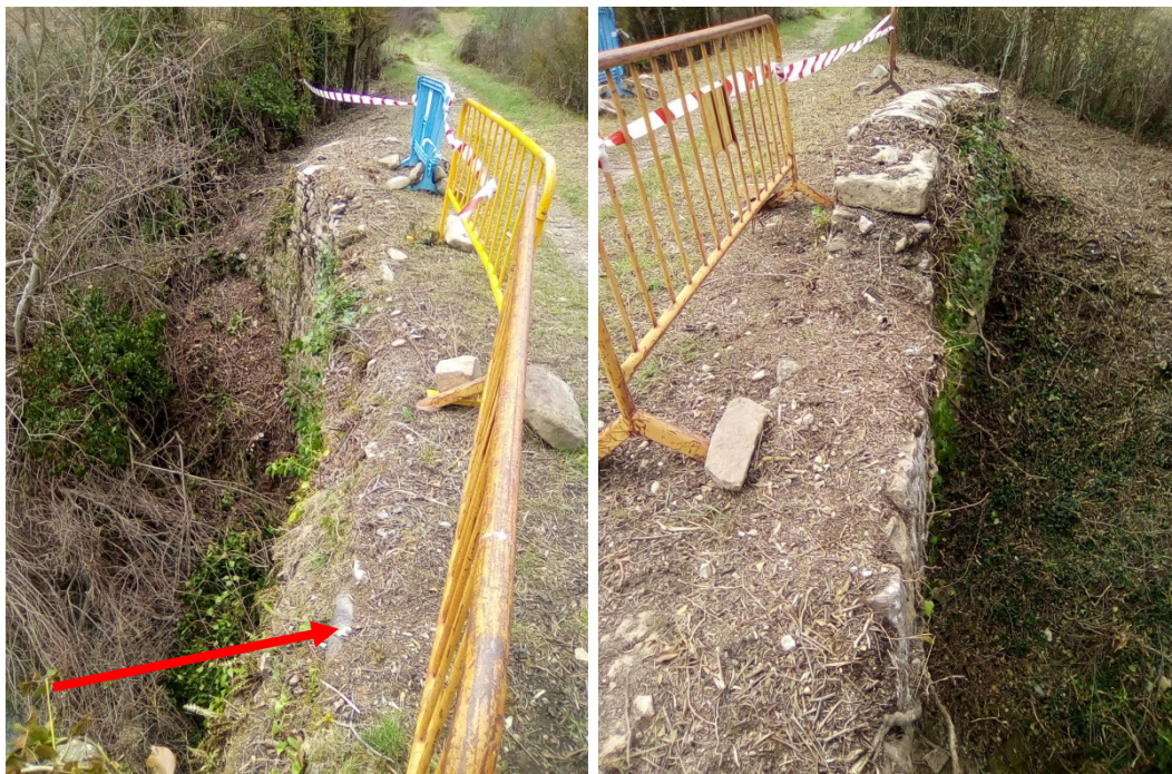
Estado de los pretils y conducción de aguas bajo éstos
