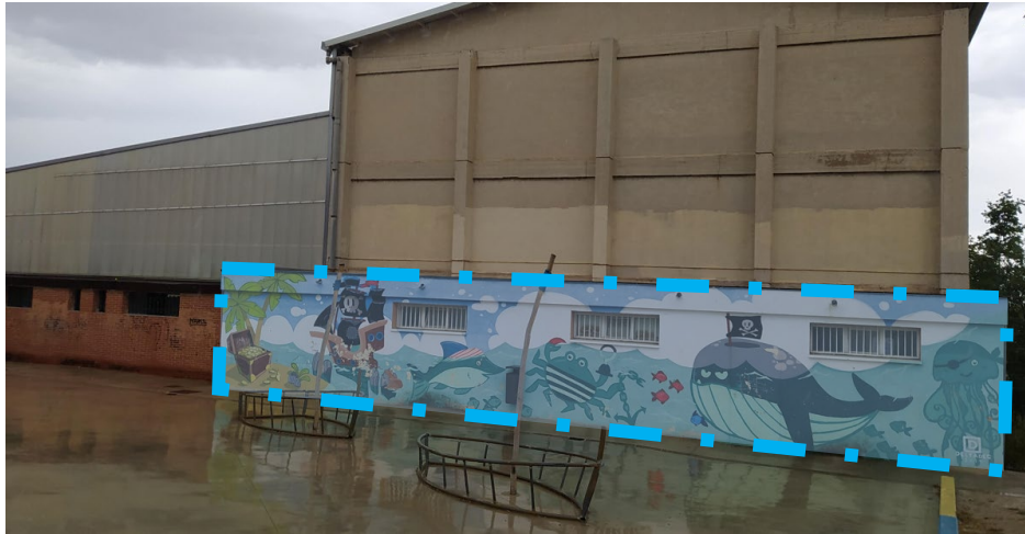
Fotografía 28: Fachada de Vestuarios nº2 a demoler para ampliación
